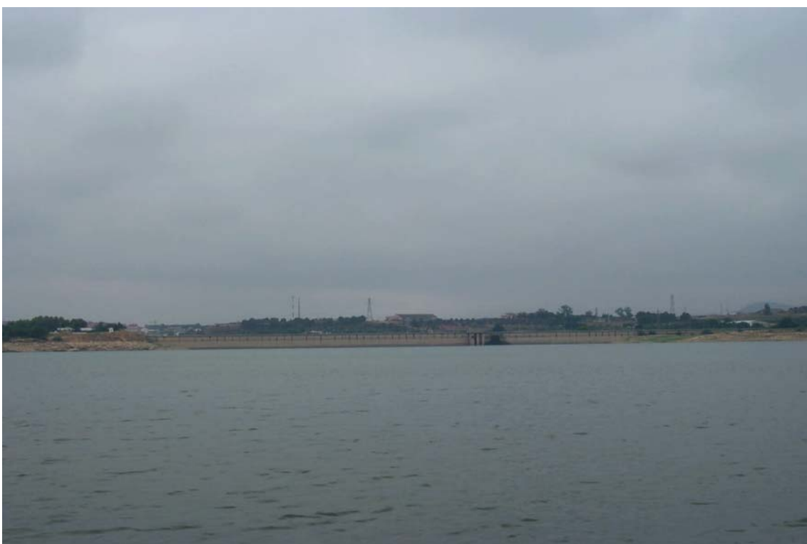
Dique de contención en el término municipal de Caspe
