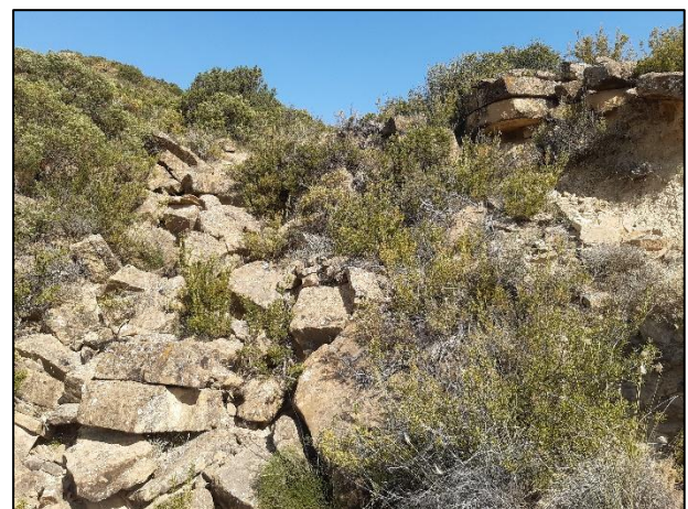
Niveles de areniscas tableados en coronación sobre lutitas en ladera
