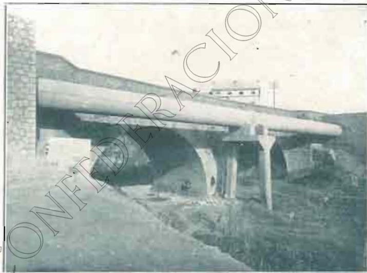
Dos tramos de 17 m. Diámetro interior 1,25 m.
