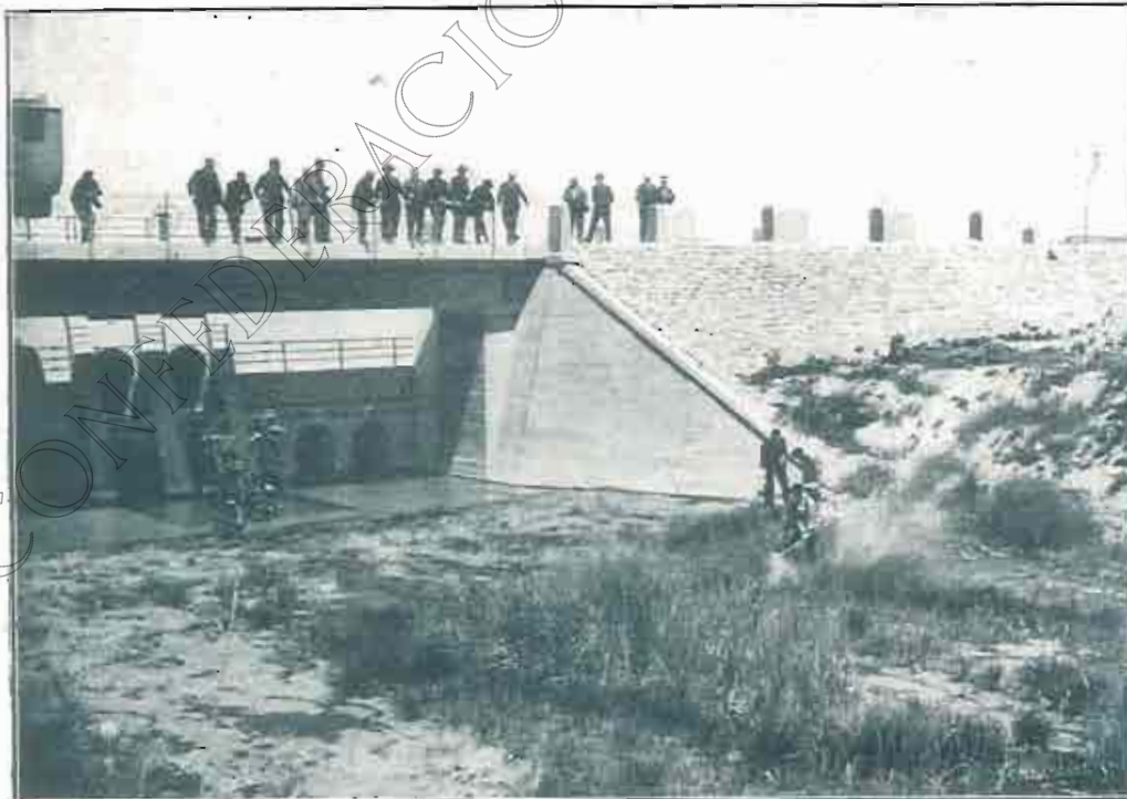
ALMUDÉVAR. BARRILECO DE 'LAS PILAS'. TRABAJOS DE LUCHA ANTILARVARIA
