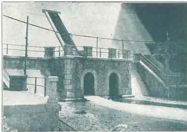
SALIDA DEL AGUA POR LA GALERÍA DE DESAGÜE DE LA PRESA AL EMPEZARÉ A ABRIR LAS COMPUERTAS DE FONDO. (Fot. Confederación)
