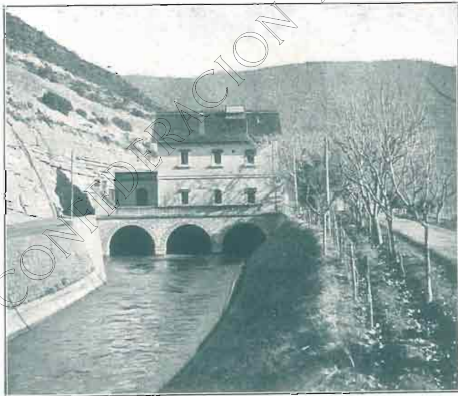
ORIGEN DEL CANAL DE URJEL: CASA DE COMPUERTAS
