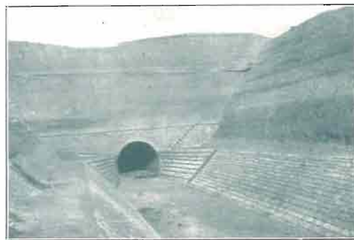
CANAL VICTORIA-ALFONSO: BÓCA DE ENTRADA AL TÚNEL DE ALFARO
