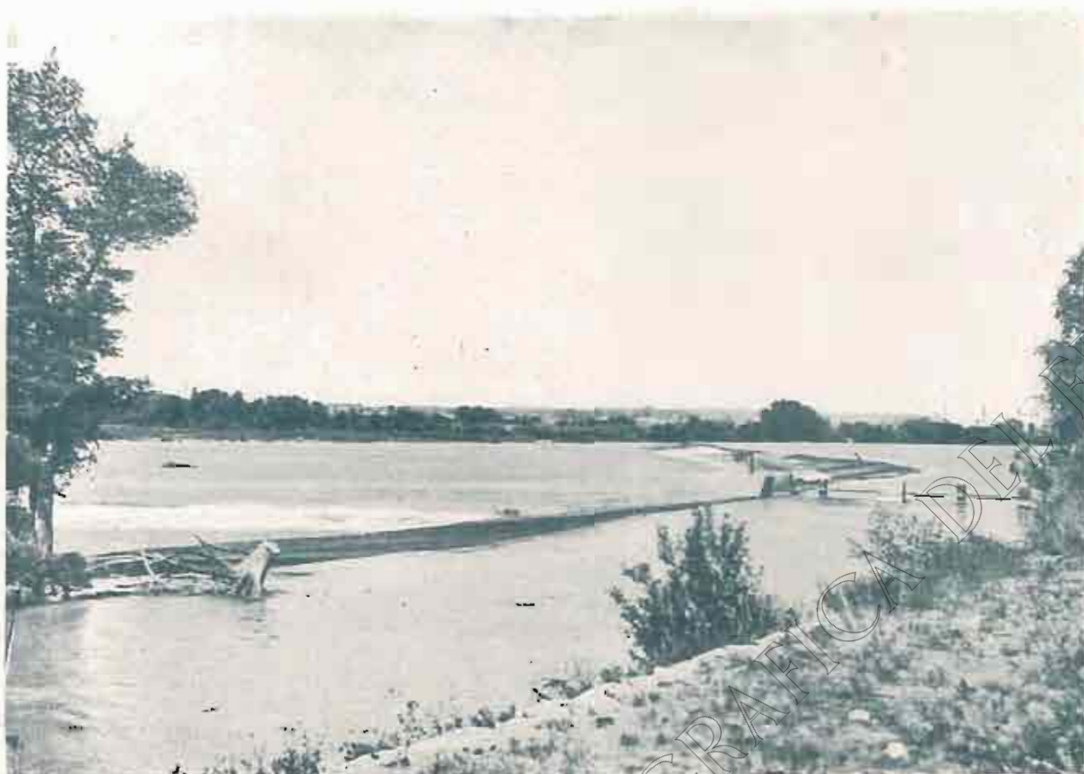
CANAL DE TAUSTE: PRESA EN EL EBRO PARA LA TOMA DE AGUAS
