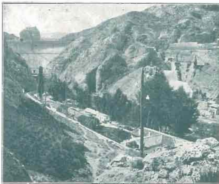
PANTANO DE CUYA-FORADADA: VISTA GENERAL DE LA OBRA.
