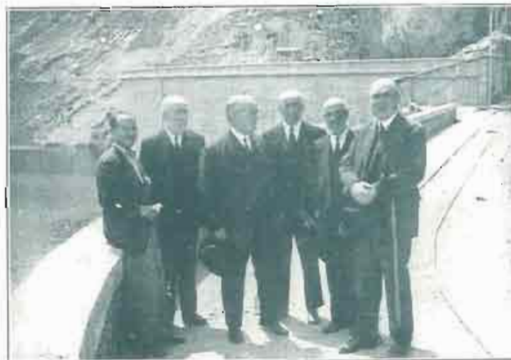
Los Ingenieros jefes de división de la Confederación: D. Fernando Hué y D. Nicolás Liria; el director de las obras del Pantano de Pena, D. Enrique Meléndez; ingeniero auxiliar don Alfonso Fernández; ayudante D. José Santos y Síndico de la zona, D. Francisco Satué.
