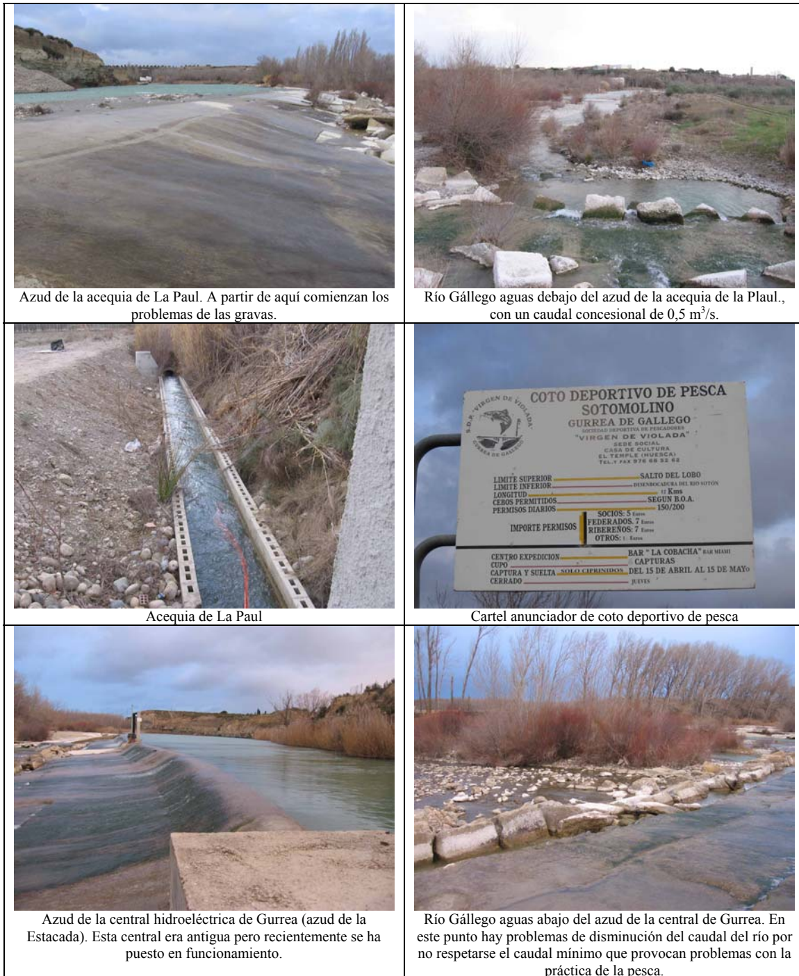
Figura 3.73: Fotos representativas de las características y problemas del río Gállego desde la central de Marracos hasta el río Sotón.
