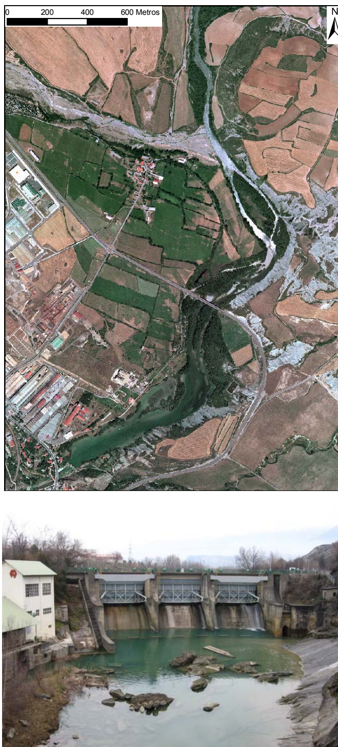
Figura 2.43: Embalse de Sabiánigo en las fotos del SigPac realizadas en el año 2002 y fotos de la presa y embalse realizadas el 16 de enero de 2007.
