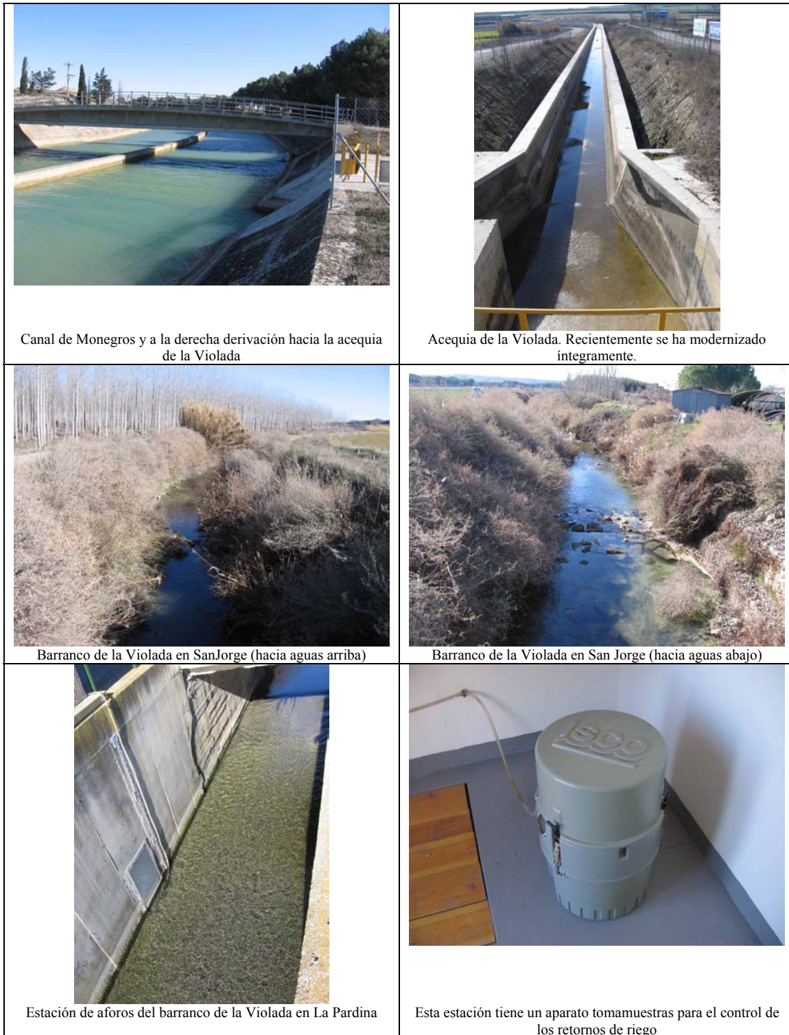
Figura 3.75: Fotos representativas de las características y problemas del barranco de La Violada.
