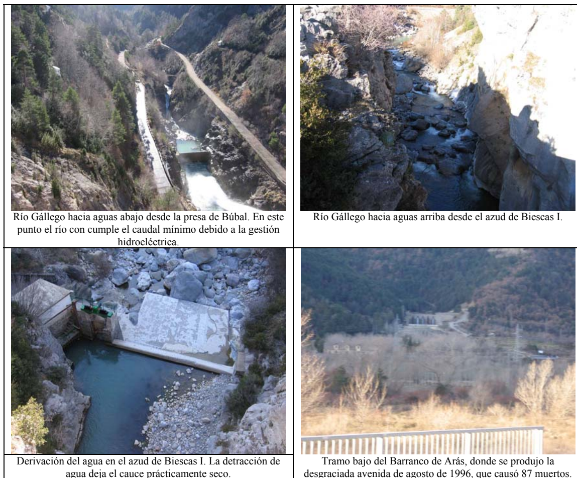
Figura 3.20: Fotos representativas de las características y problemas del río Gállego desde la presa de Búbal hasta el río Sía.
