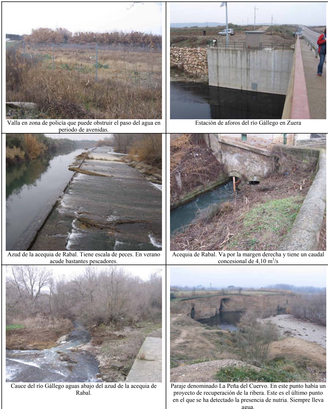
Figura 3.77 (Continuación): Fotos representativas de las características y problemas del río Gállego desde el río Sotón hasta su desembocadura en el Ebro.
