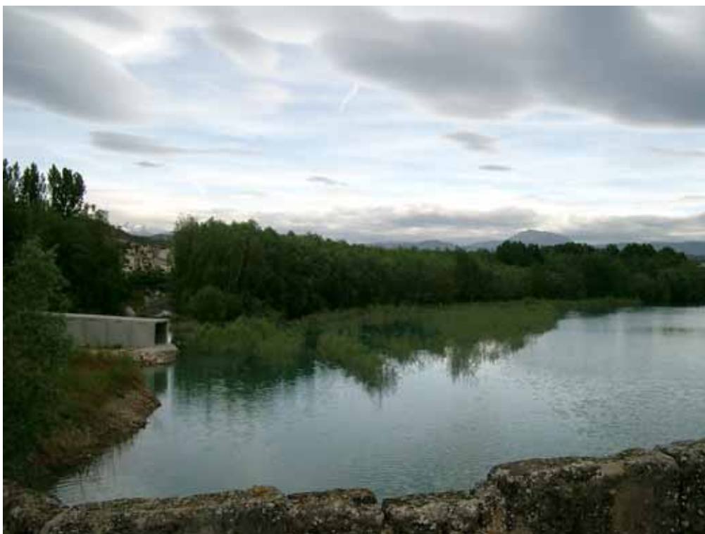
Obra de cruce y canalización de barranco desde puente románico
