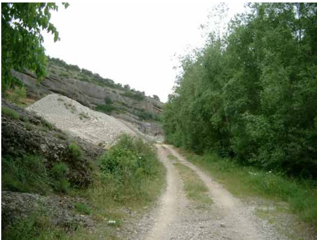
Depósito de gravas en la m. i. de la cola del embalse
