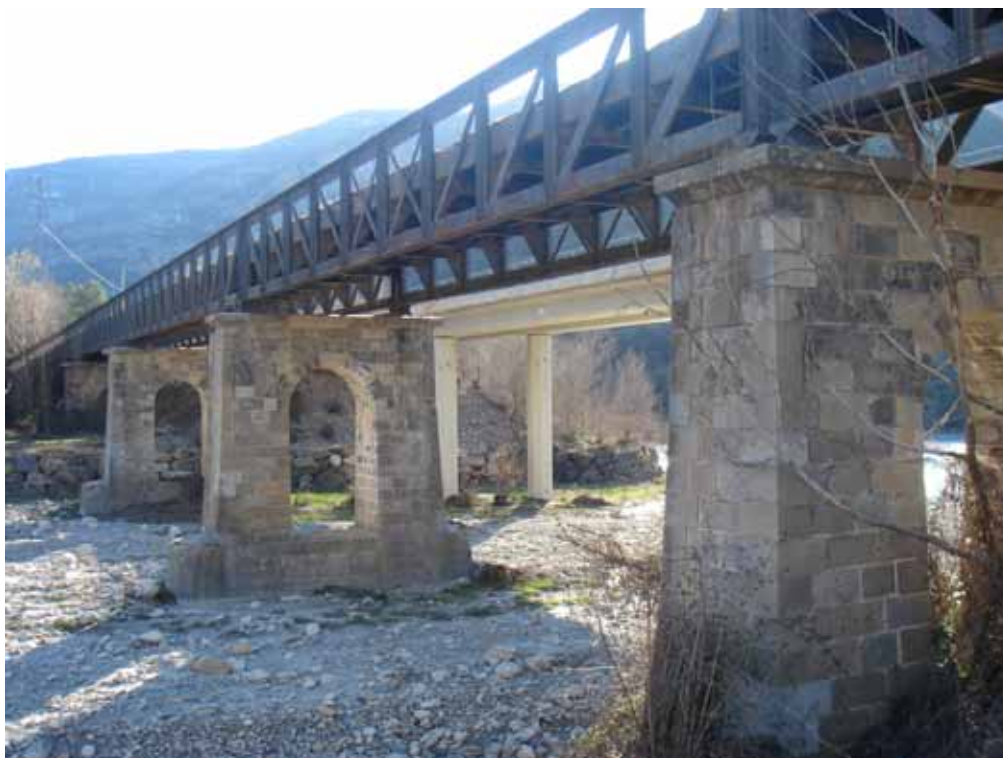
Puentes sobre el Barranco Bacamorta
