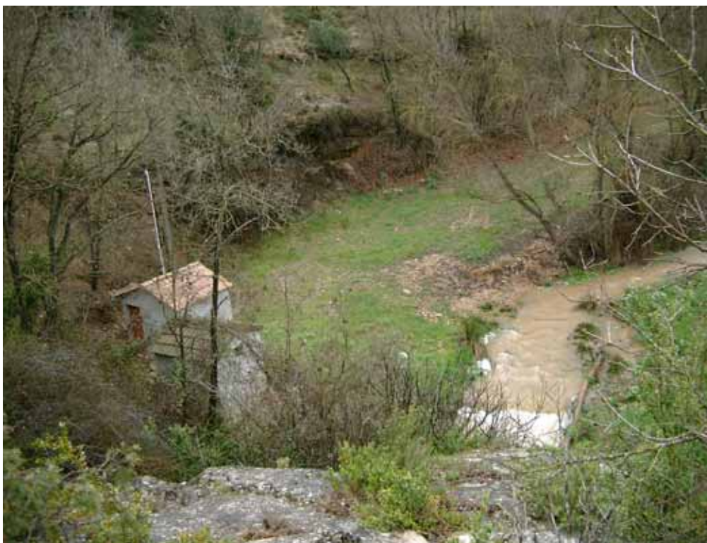
Manantial de Puybert y toma de abastecimiento de Aler
