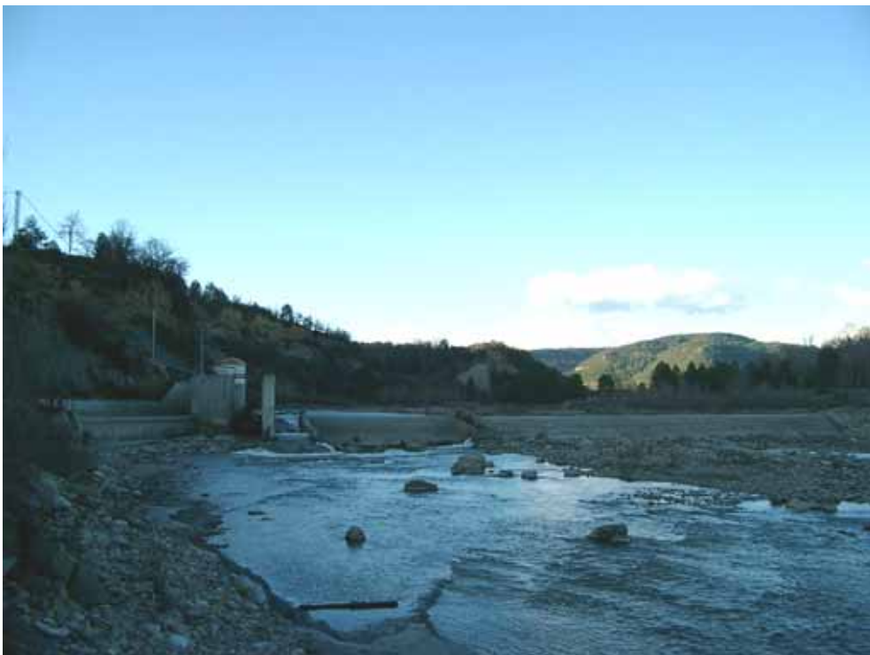
Azud del salto hidroeléctrico de Graus. Detrás captación de aguas de la ciudad
