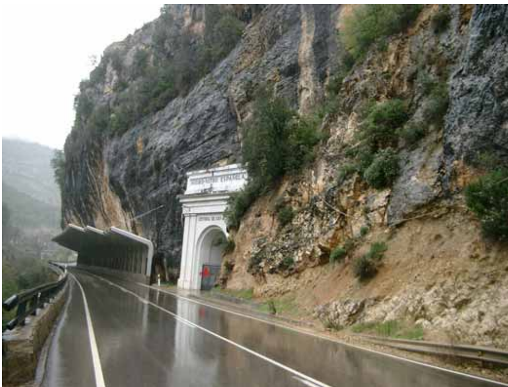
Túnel de acceso a la central de San José de H.N.E.
