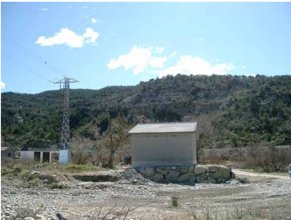
Toma del abastecimiento de Castigaleu
