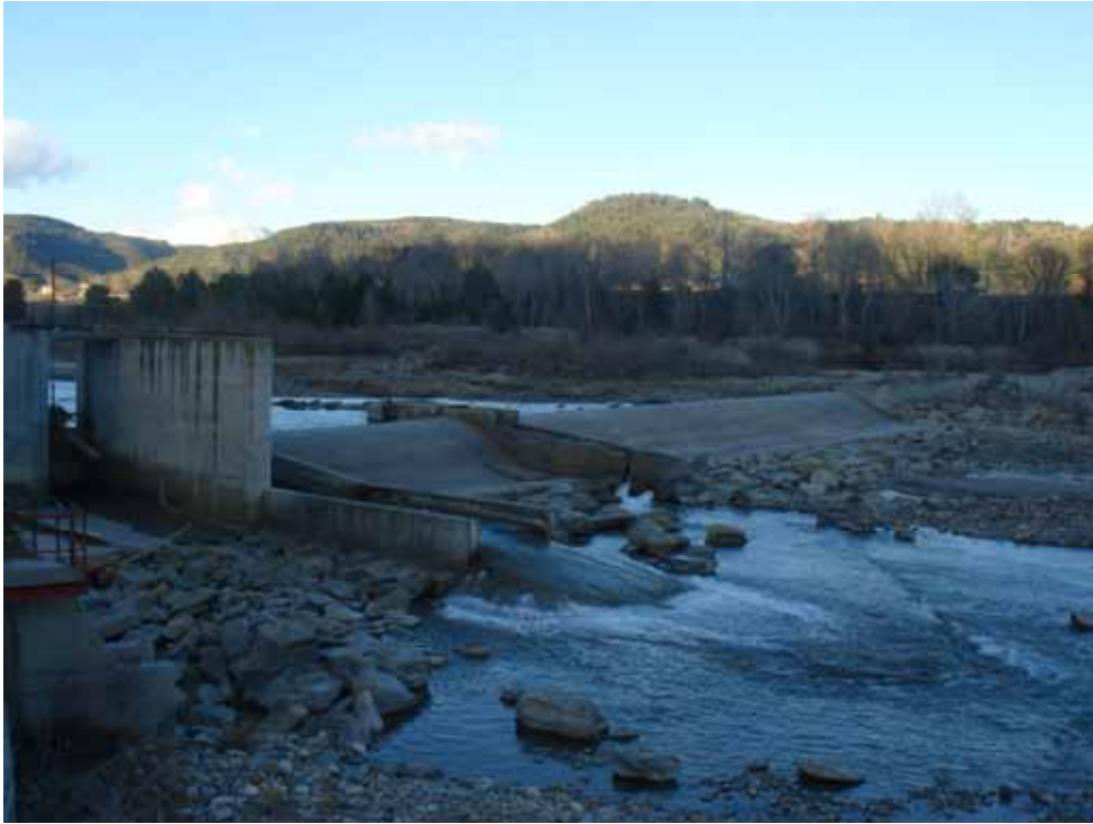
Caudales ecológicos y escala de peces
