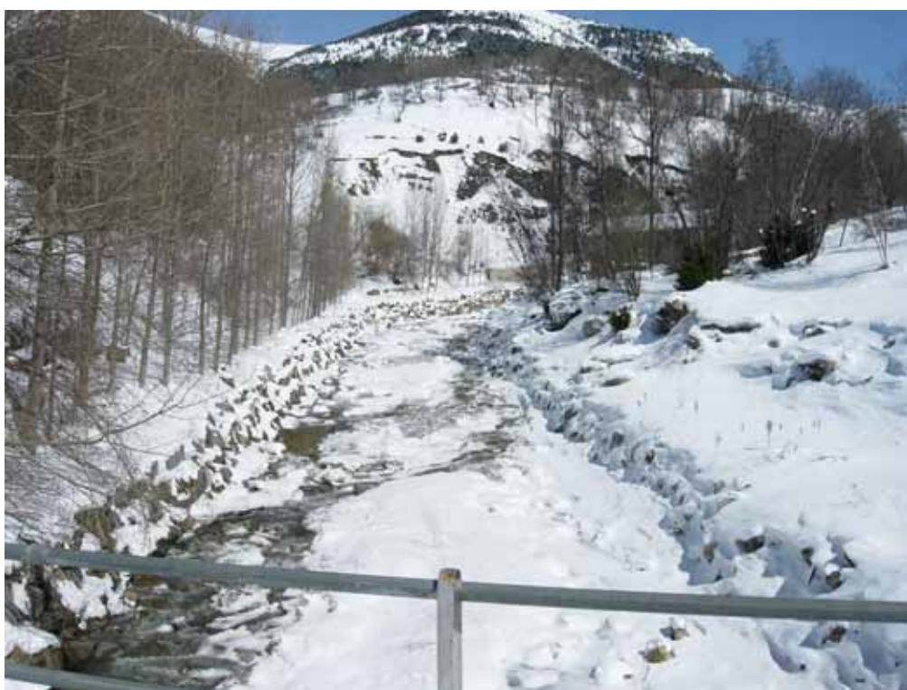
Canalización río Remáscar en Cerler
