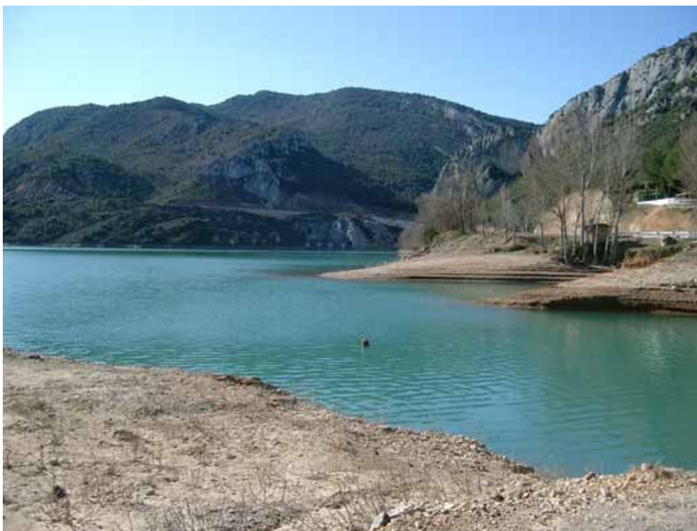
Estrechamiento del cauce donde se localiza la presa. Al fondo el aliviadero superficial en la M. I.
