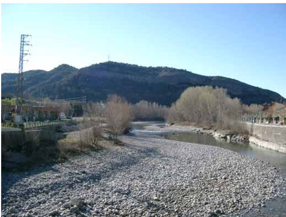
Depósitos aluviales en el encauzamiento
