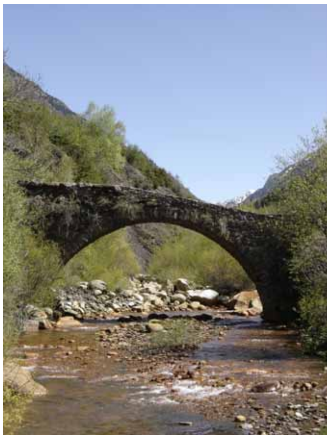
Puente aguas arriba del casco urbano de Benasque
