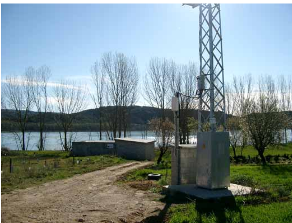
Toma abastecimiento de La Puebla de Castro
