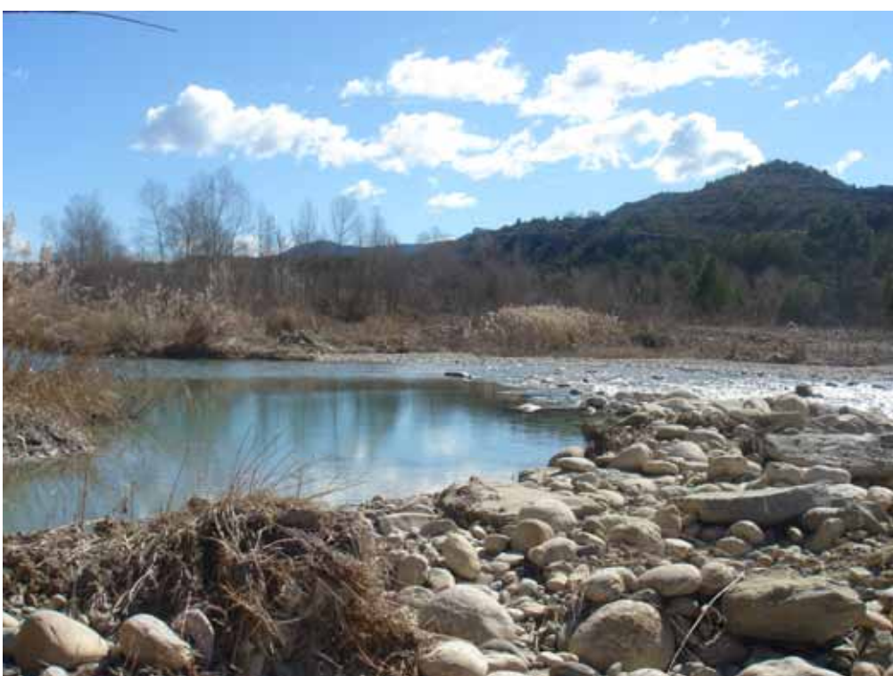
Toma de la acequia de riego
