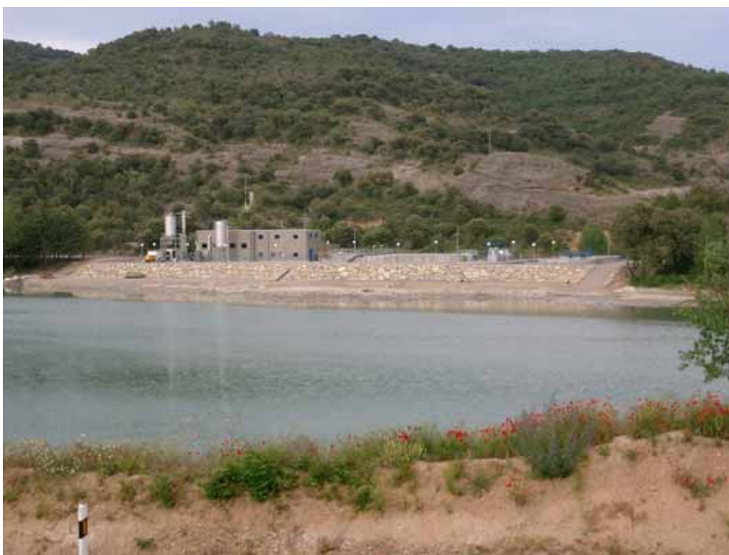
Depuradora de Graus desde la m.d.
