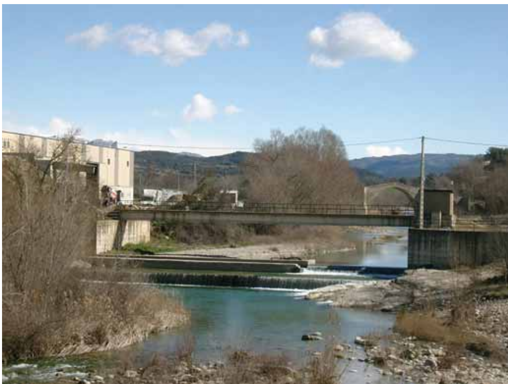
E. A.-47 vista desde aguas abajo
