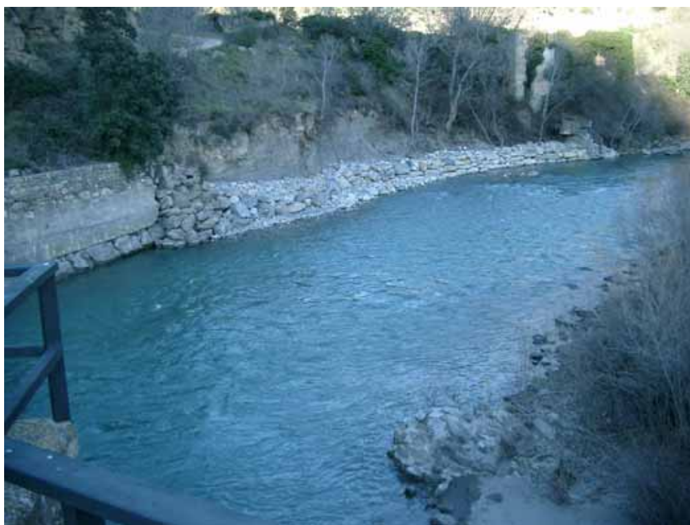
Escollera protección y muro del puente de Sta. Liestra
