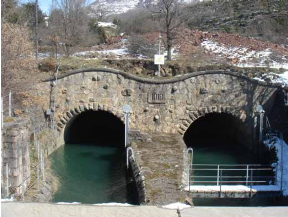
Canal de aportación al salto de El Run.
