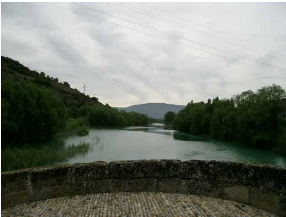
Puente antigua N-123 desde puente románico
