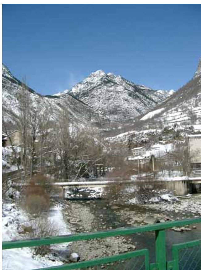
Rio Eriste. A la derecha desagüe de la central del mismo nombre
