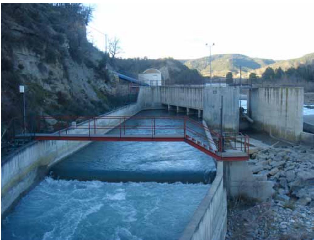
Cámara de decantación de la toma del salto
