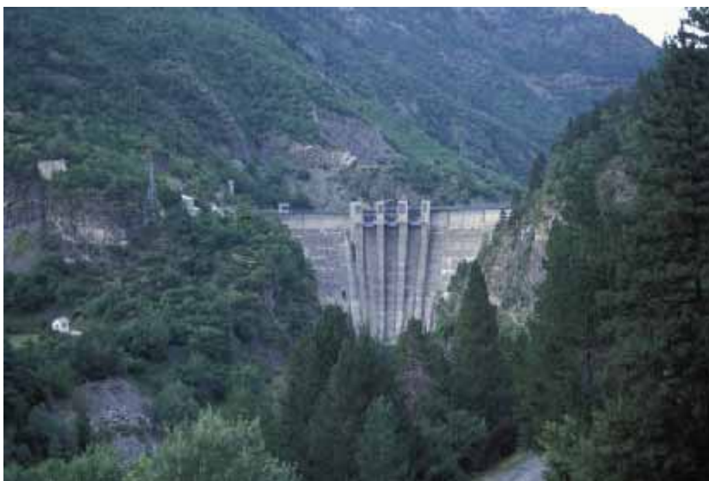
Presa de Paso Nuevo. Vista desde aguas abajo.
