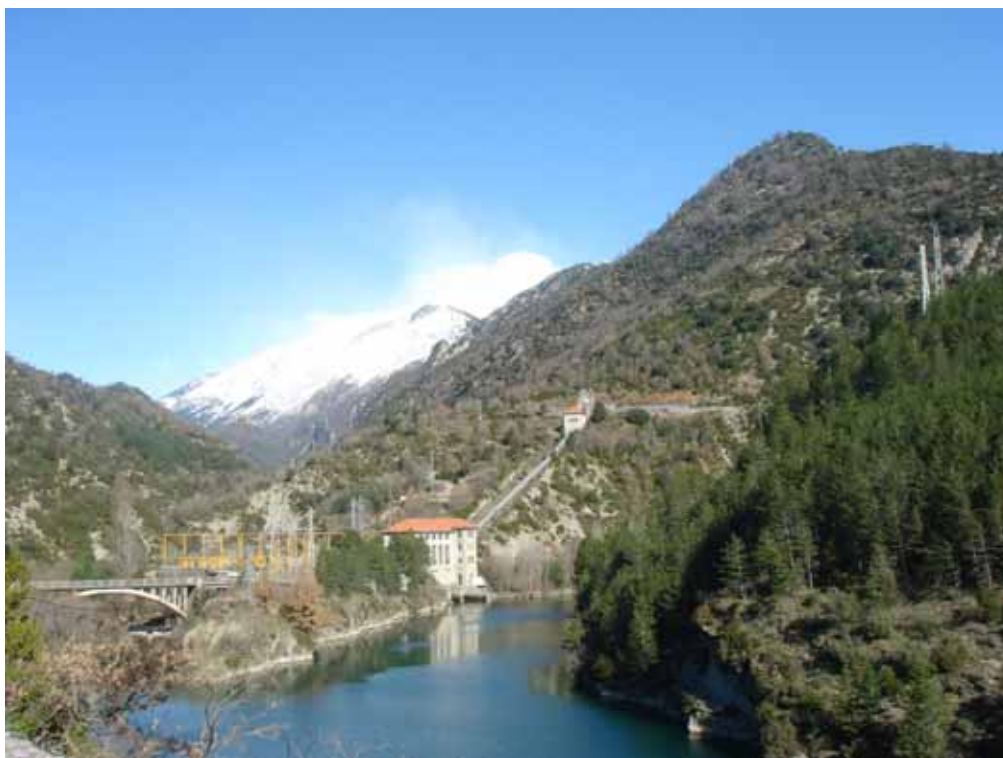
Cámara de carga, tubería forzada y central del salto hidroeléctrico de Argoné
