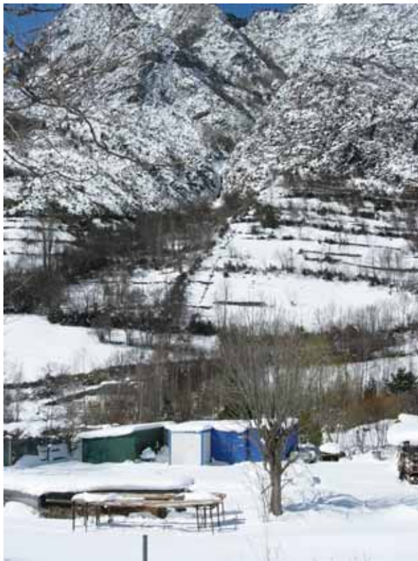
Salto de La Ruda: tubería de presión
