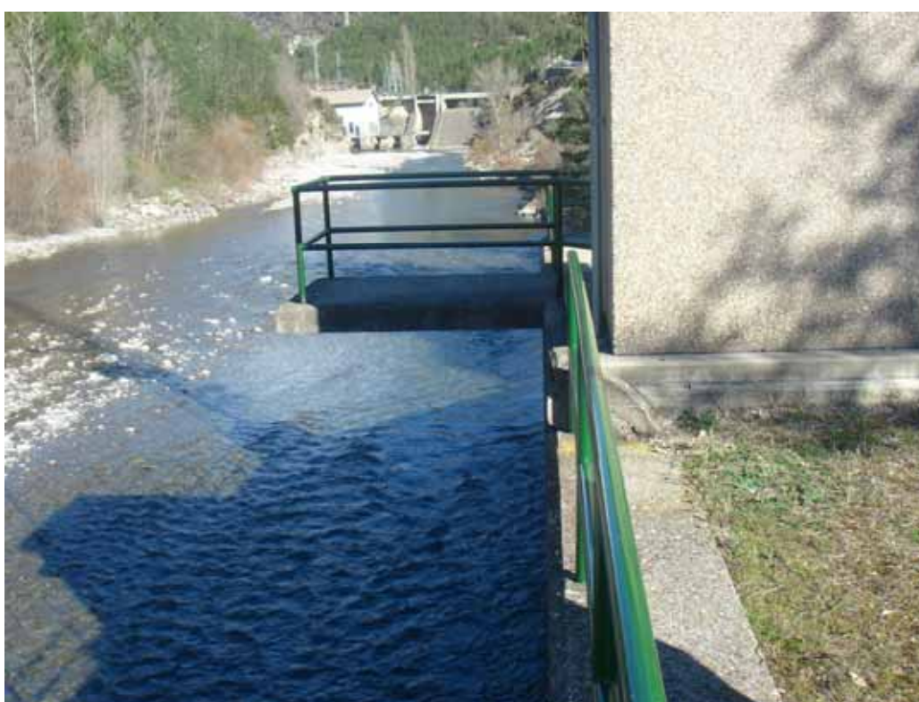
Lecho móvil de la estación de aforos. Al fondo azud de Campo
