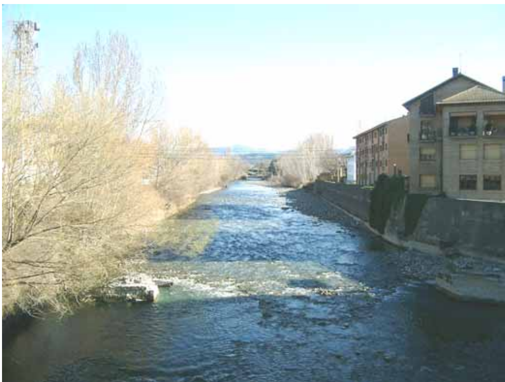
Encauzamiento del Ésera en Graus, aguas arriba del puente de la A-1605
