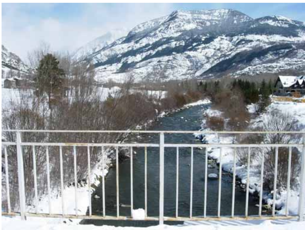
Puente de paso del Ésera. Urbanización de la m. i.
