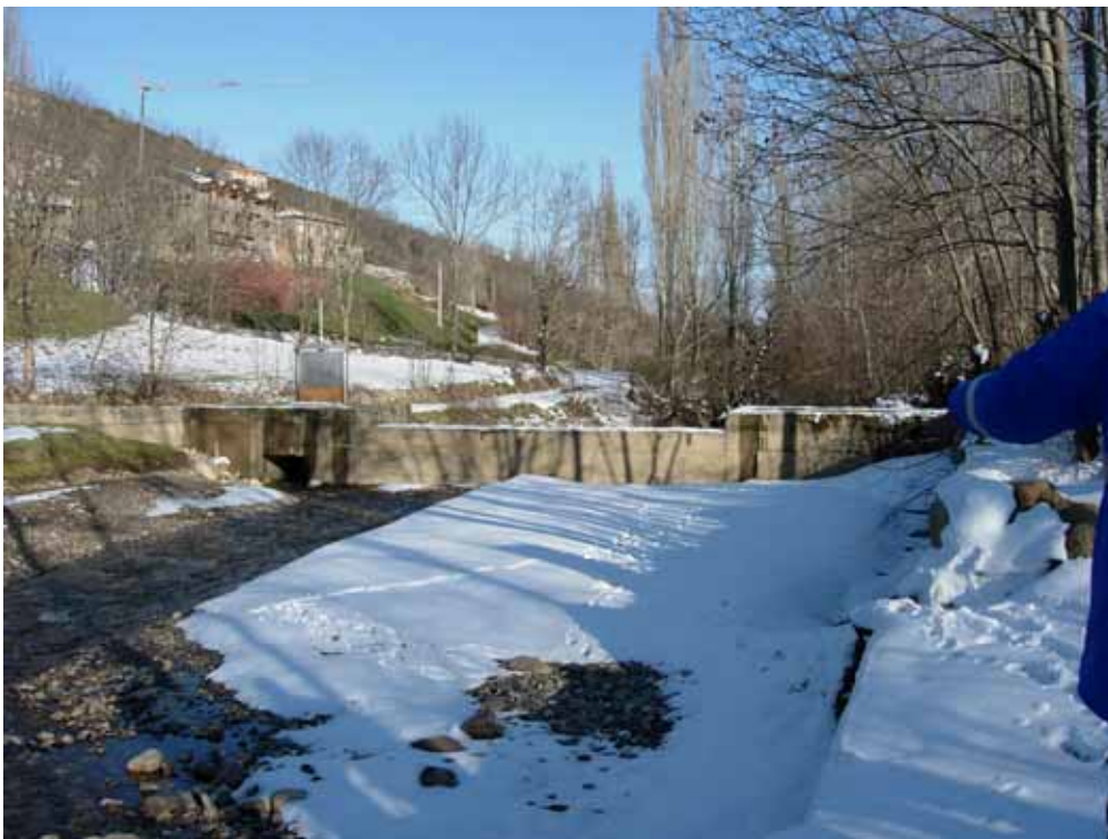
Azud con compuerta, frente a zona de esparcimiento
