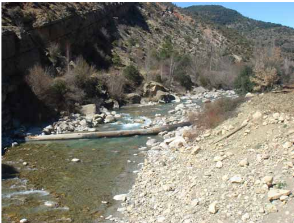
Cauce del Isábena aguas arriba de Serraduy. Tubería de riegos y de minicentral
