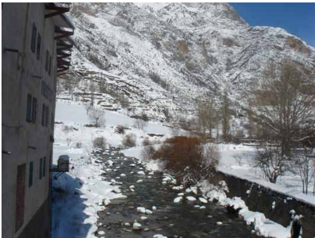
Encauzamiento aguas arriba puente medieval
