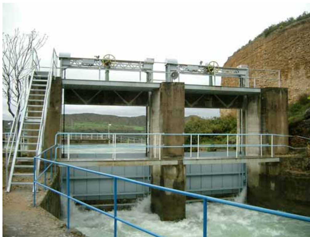
Compuertas del Canal de Aragón y Cataluña
