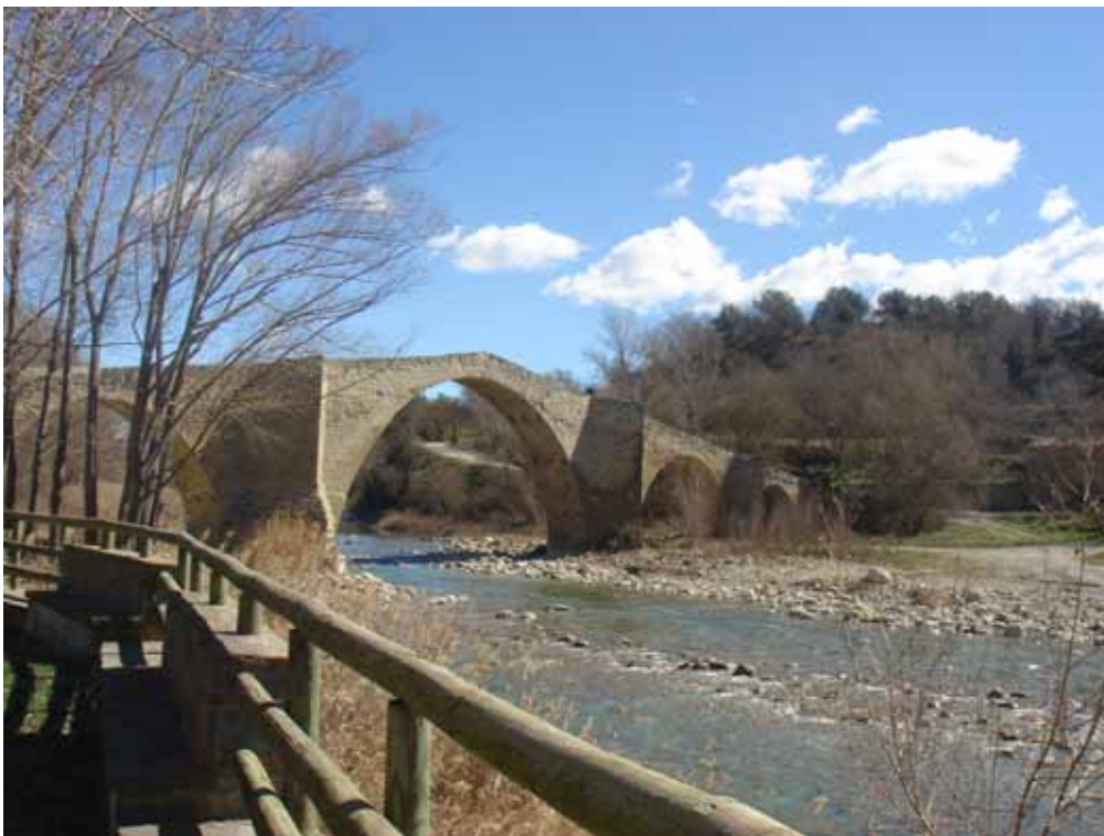
Puente de Capella
