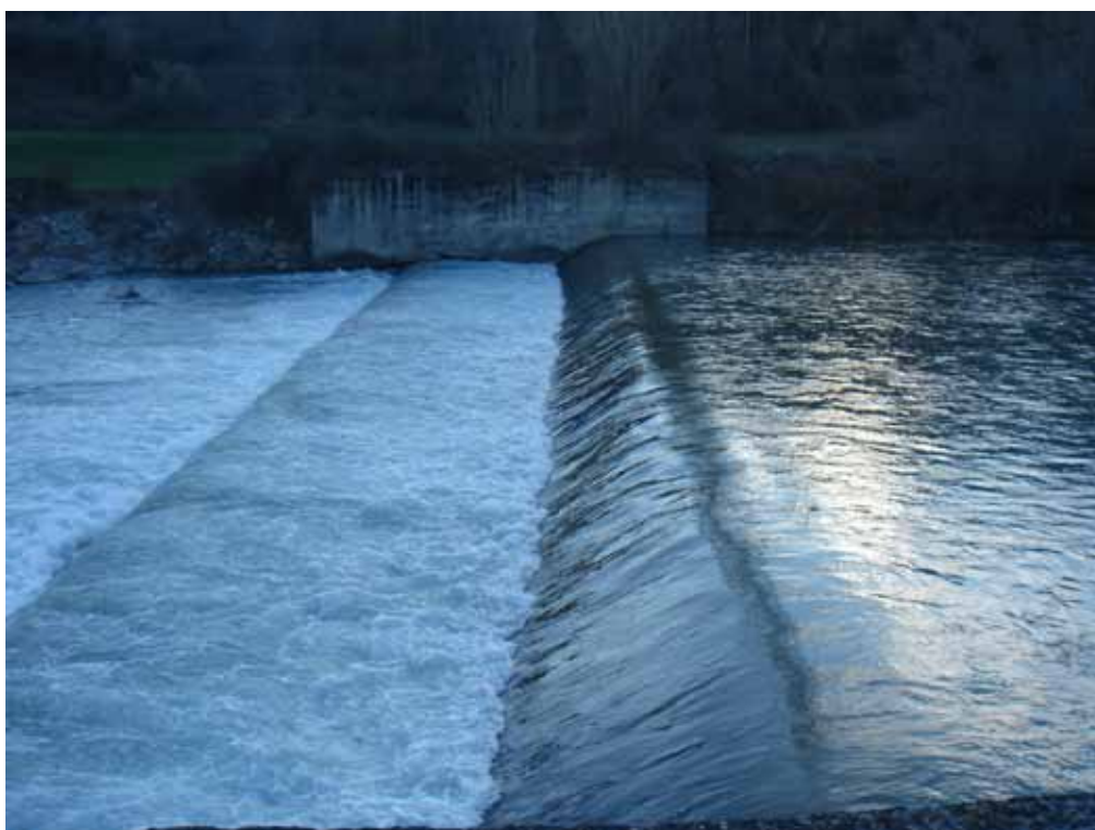
Azud de la Acequia de Sta. Lucía. Vista longitudinal.
