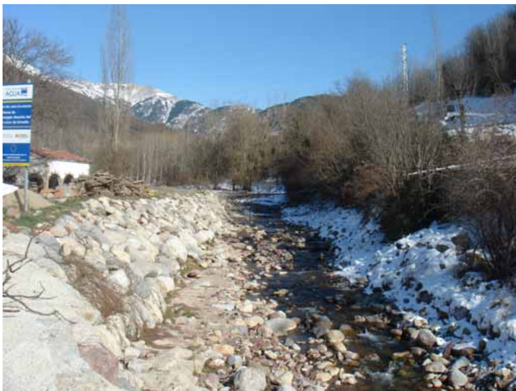
Canalización Barranco de Urmella
