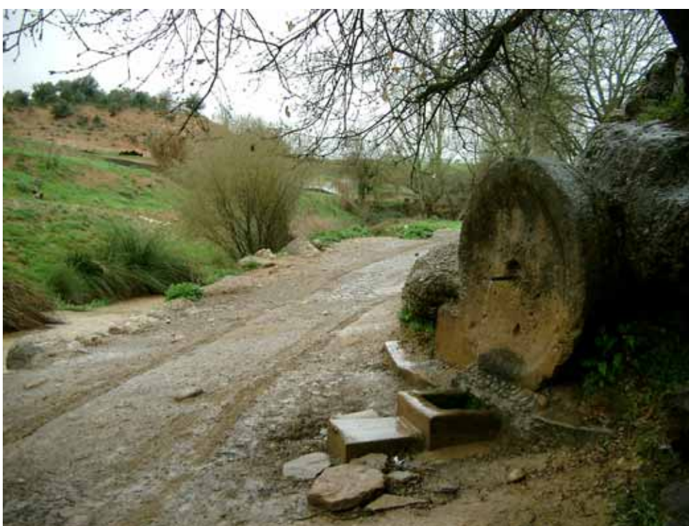
Torres del Obispo. Fuente en zona de los molinos reformada por obras de la nueva N-123
