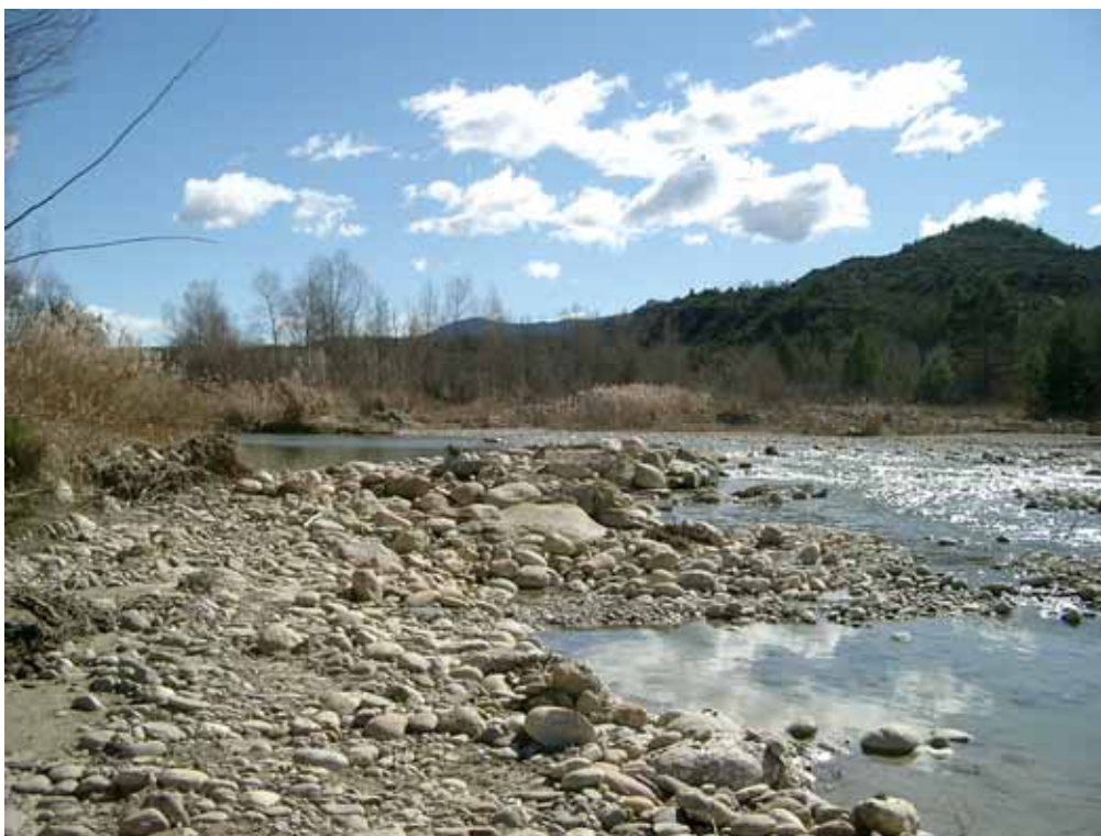
Azud de riegos construido con material del cauce
