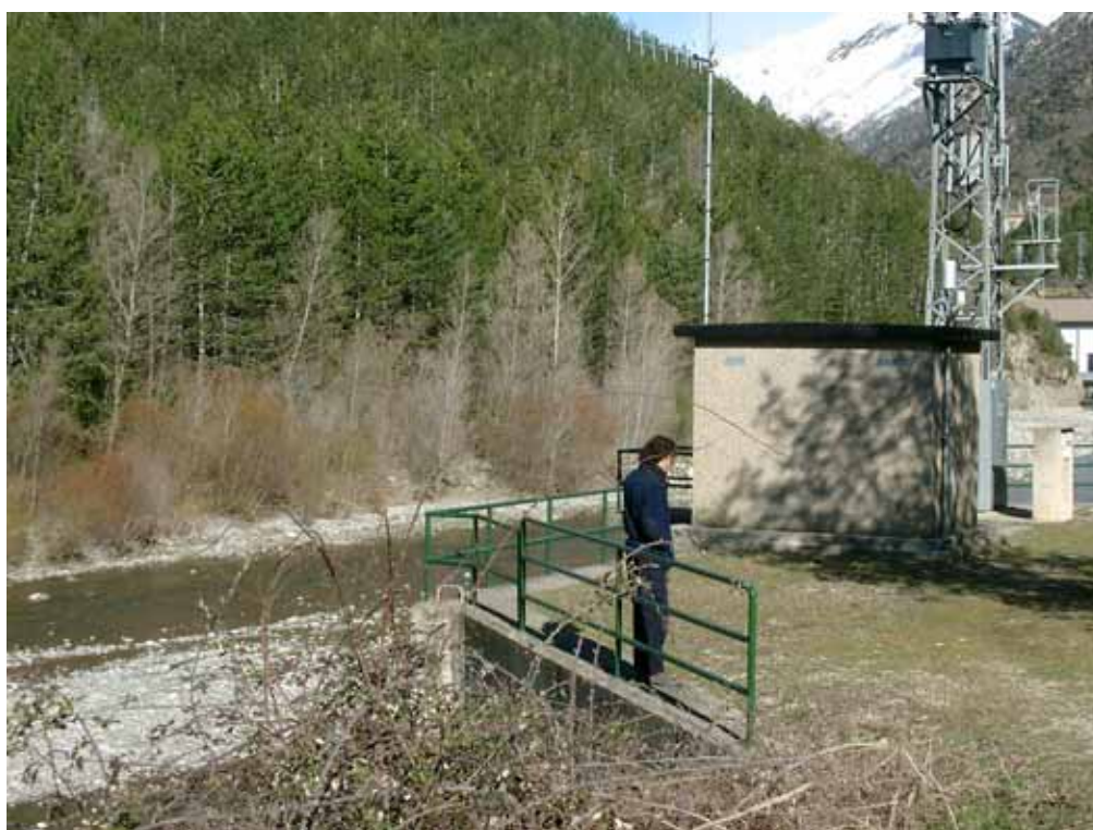
Estación de Aforos E.A.-258, Ésera en Campo
