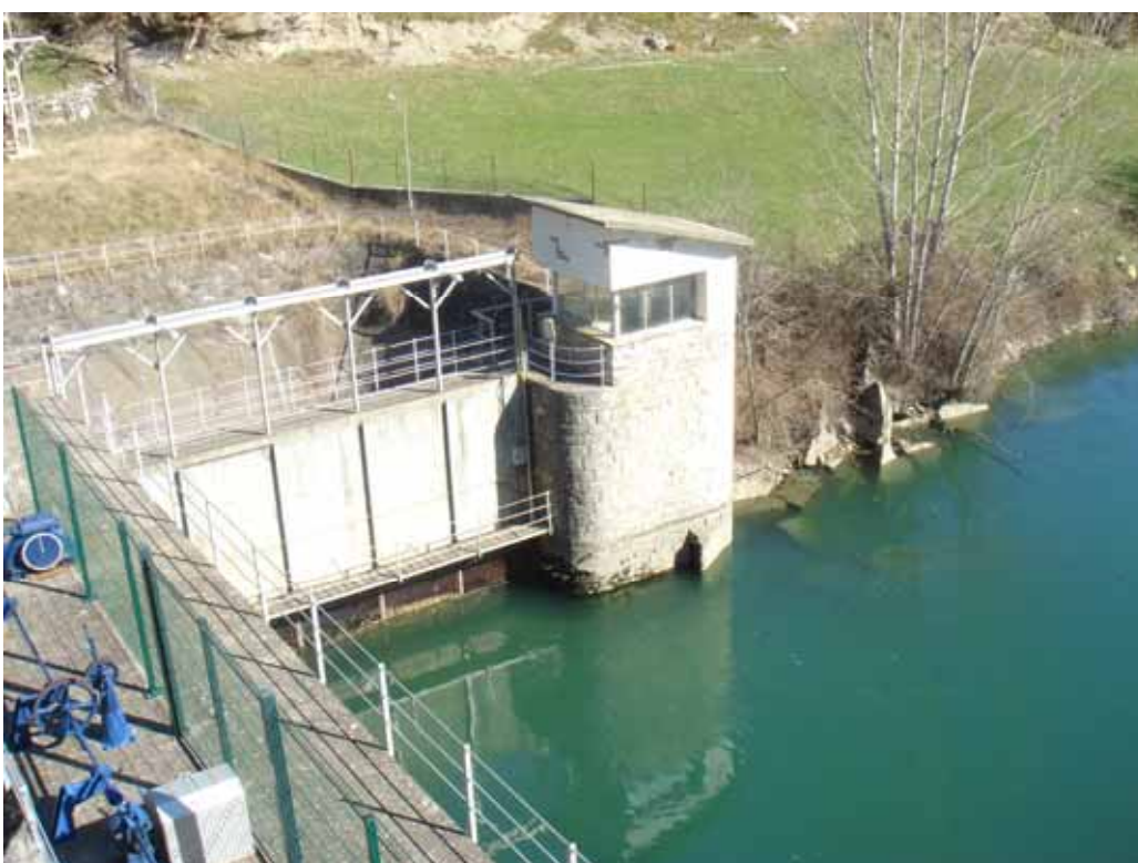
Azud de Seira. Toma del salto hidroeléctrico de Argoné
