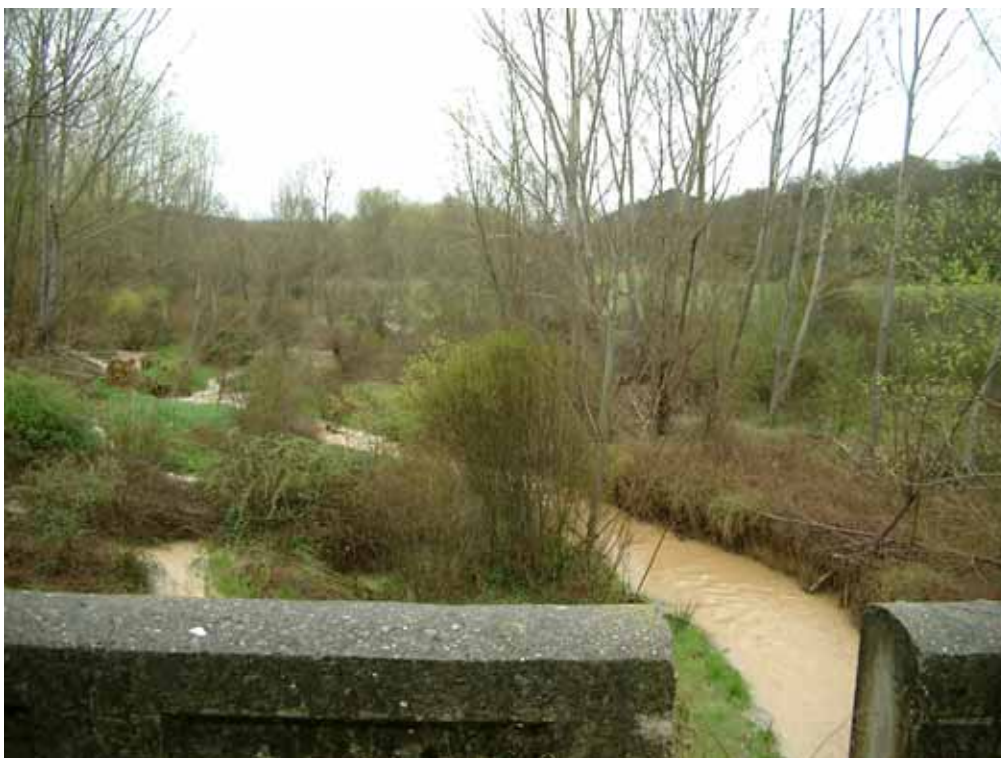
Puente sobre el Sarrón de la carretera a Aguinalú
