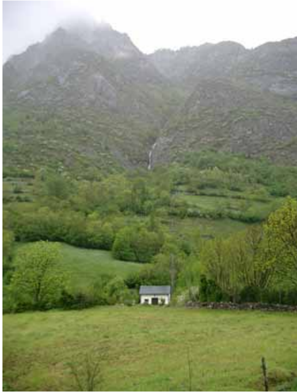
Central hidroeléctrica de La Ruda
