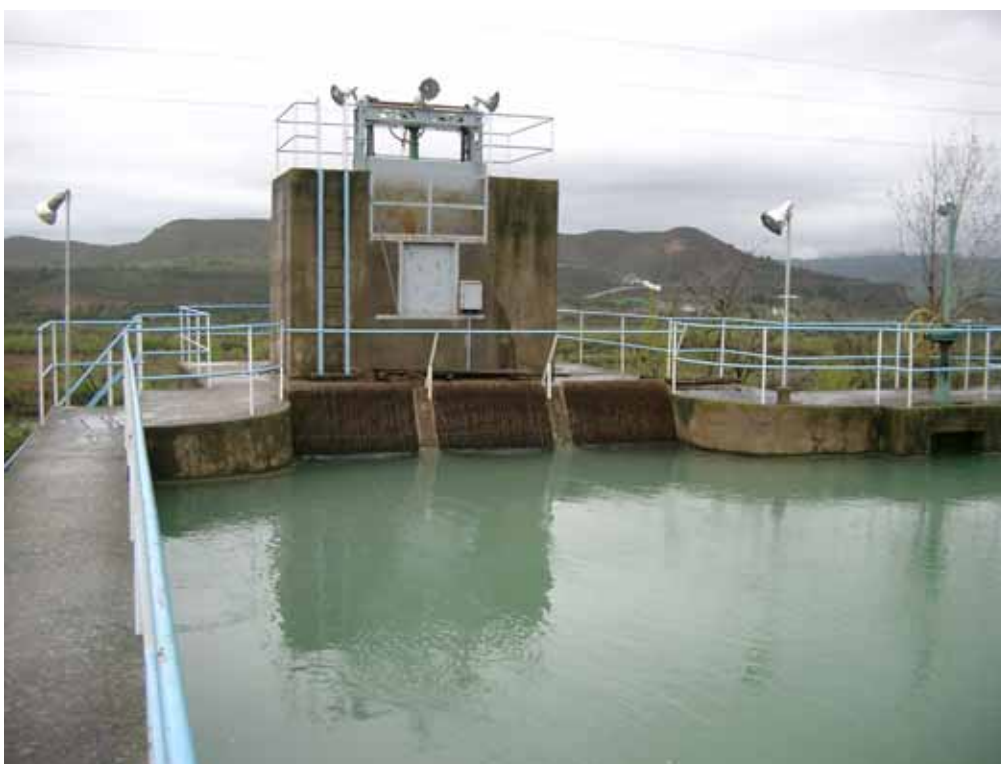
Toma de agua del salto de El Ciego
