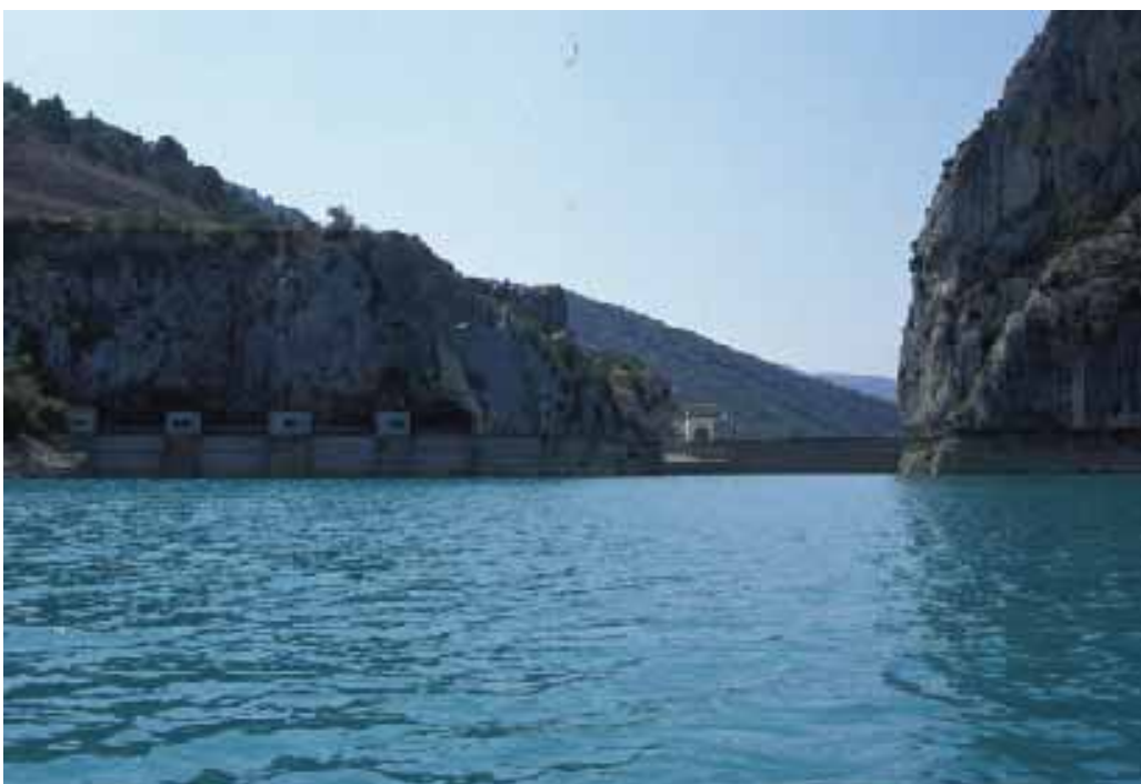
Embalse de Joaquín Costa o Barasona. Aliviaderos y presa desde embalse
