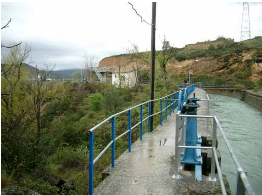
Compuerta de la Acequia de Estada hacia el barranco
