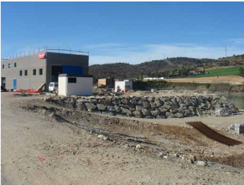
Escollera de protección y depuradora de graus en m.i.
