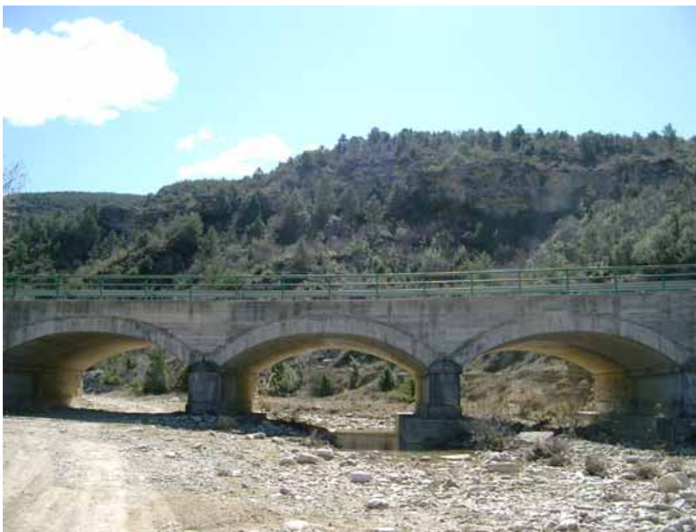
Puente de la A-1605 sobre el Ceguera
