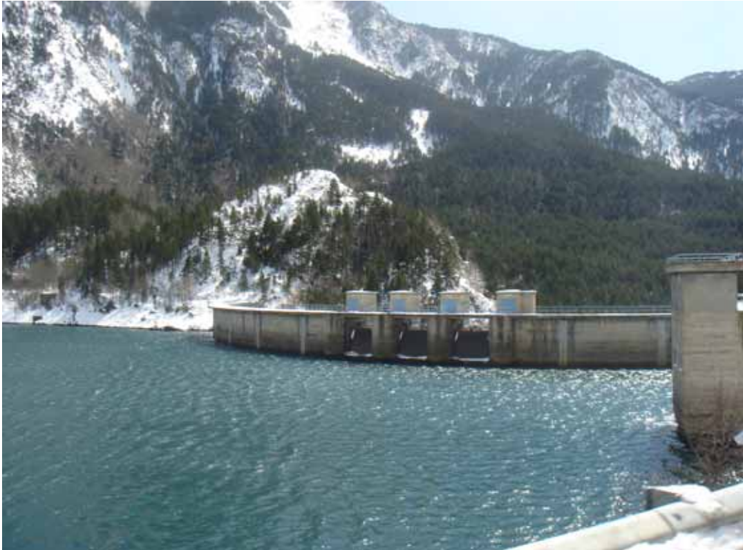
Presa de Paso Nuevo
