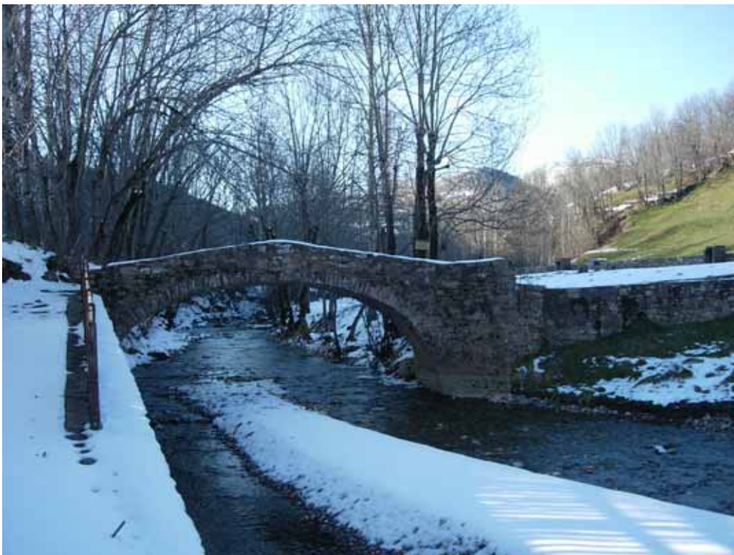
Puente sobre el Isábena, antes de la canalización
