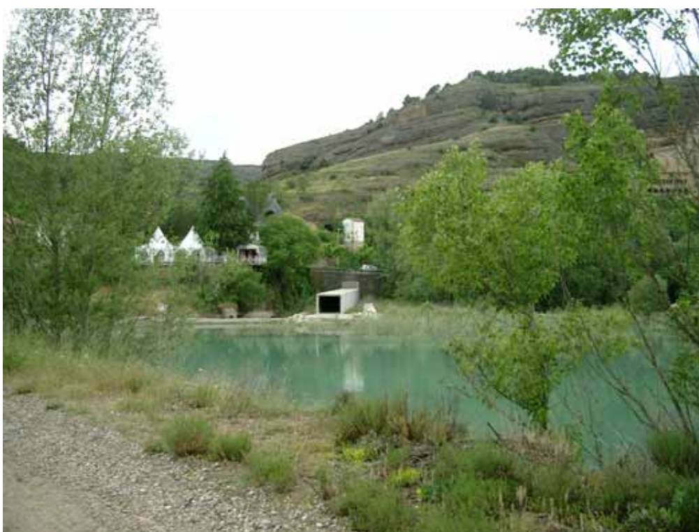
Obra de cruce y canalización de barranco desde margen opuesta
