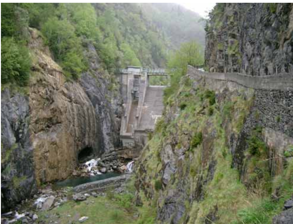
Azud de Estós y camino hacia el alto valle
