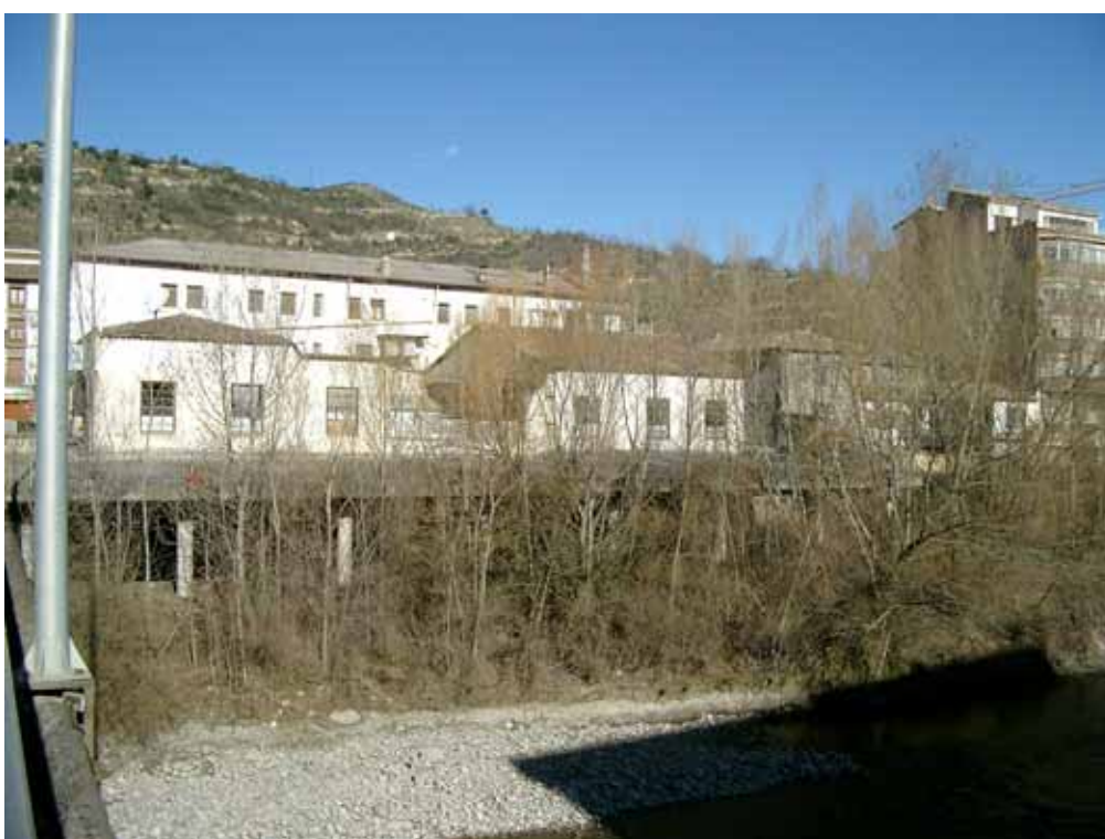
Estructura sobre el cauce del Ésera en puente A-1605
