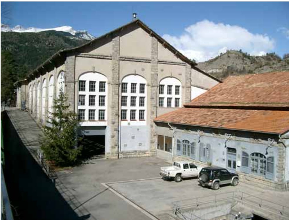
Central de Seira del salto hidroeléctrico de El Run
