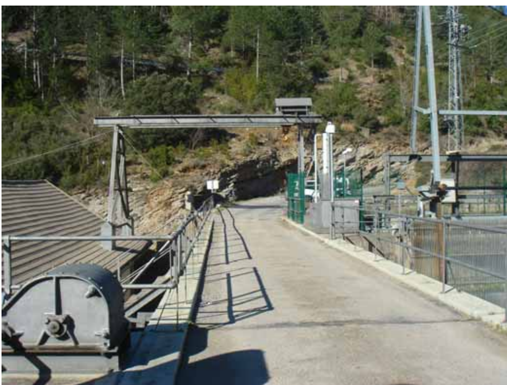
Camino de coronación del azud y carretera a Senz y Viu
