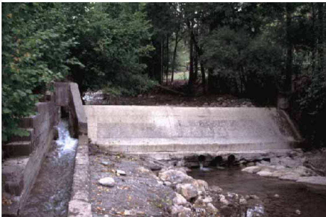
Desagües de fondo y canal de derivación
