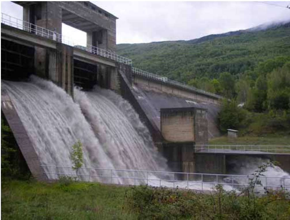
Aliviaderos presa de Linsoles
