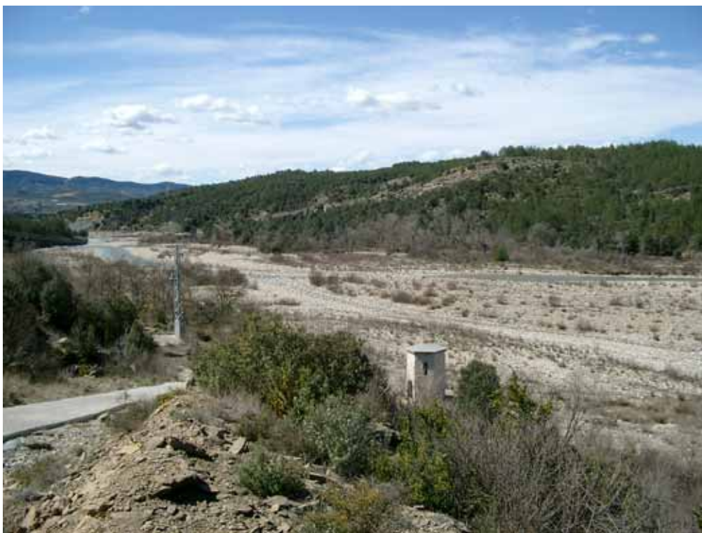
Toma del abastecimiento de Lascuarre
