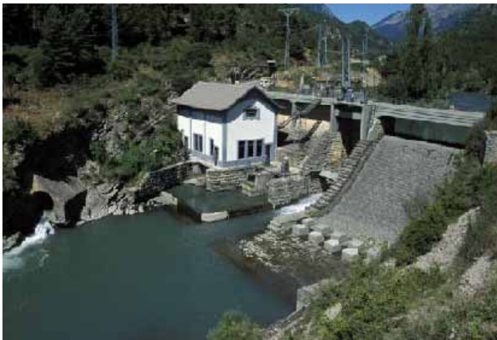
Central pie de presa del Salto Auxiliar de Campo
