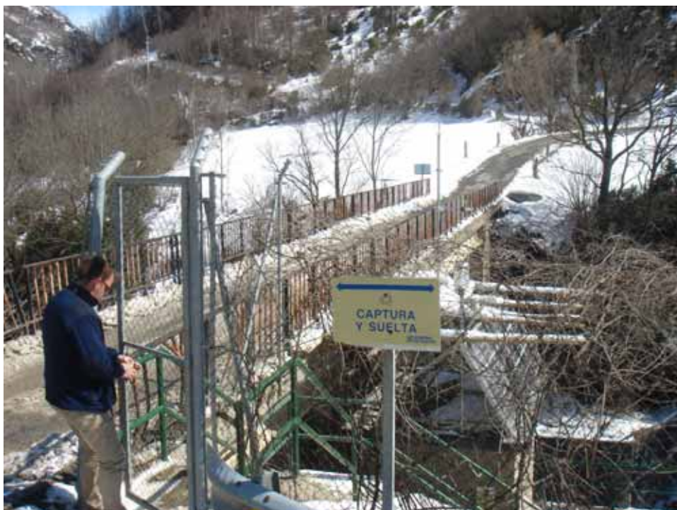
Puente de acceso a Eresué y Ramastué y estación foronómica
