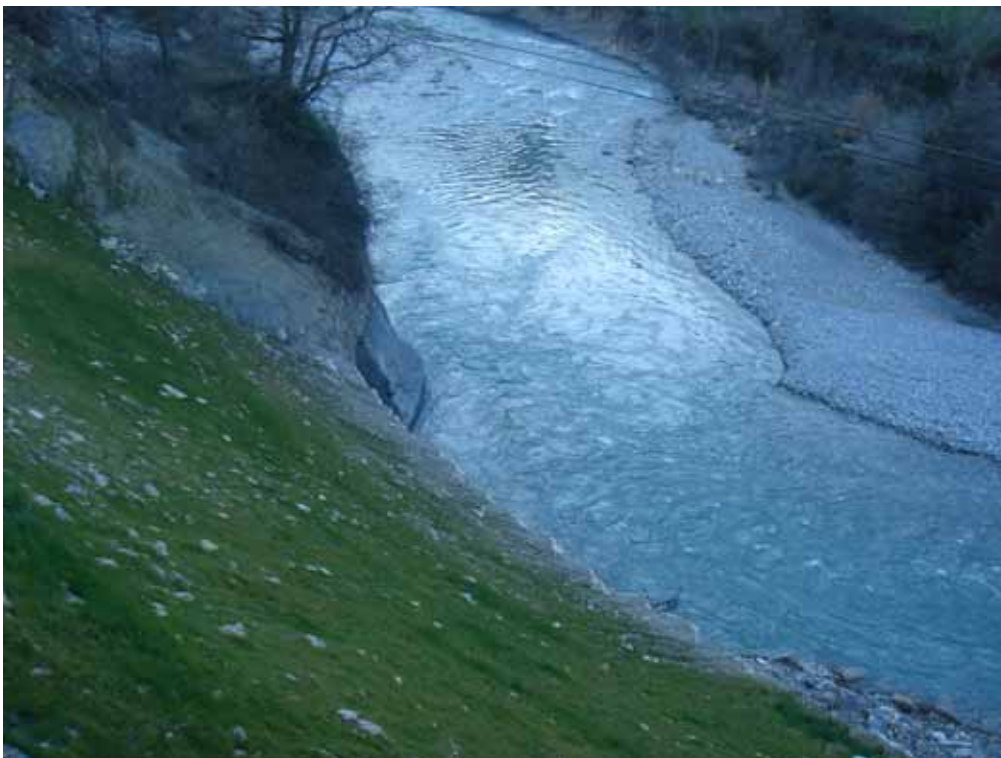
Protección talud de la A- 139
