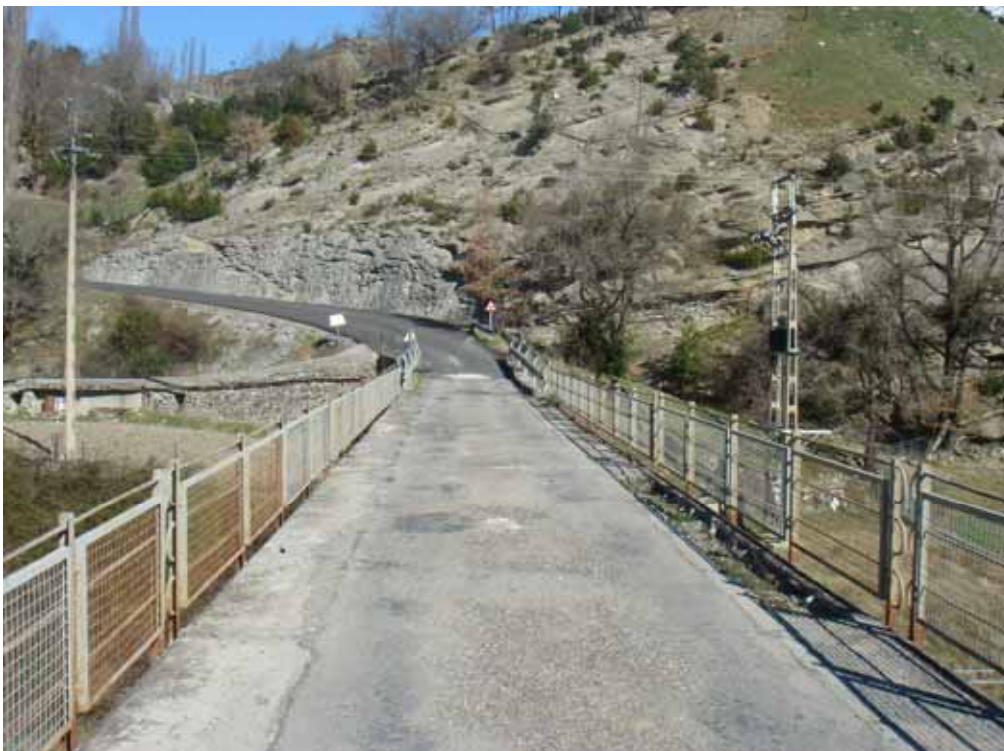
Puente de la carretera a Barbaruens cimentado sobre el azud de Seira
