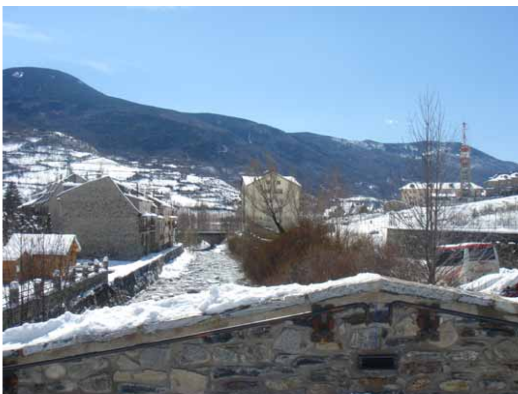
Encauzamiento río Ésera en Benasque aguas abajo del puente medieval reconstruido
