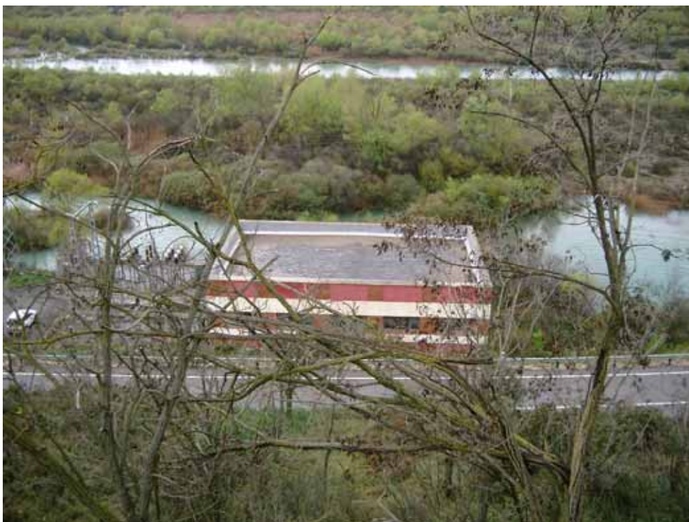
Central del salto hidroeléctrico de El Ciego. Al fondo el Cinca
