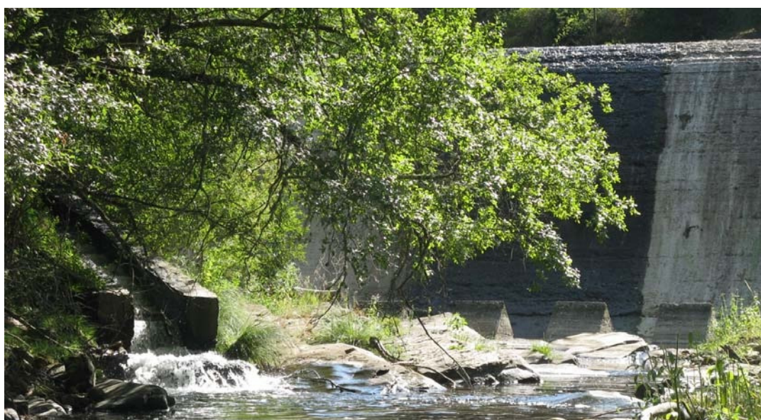
Fig. 4. Vista del azud y la escala de peces existente desde aguas abajo
