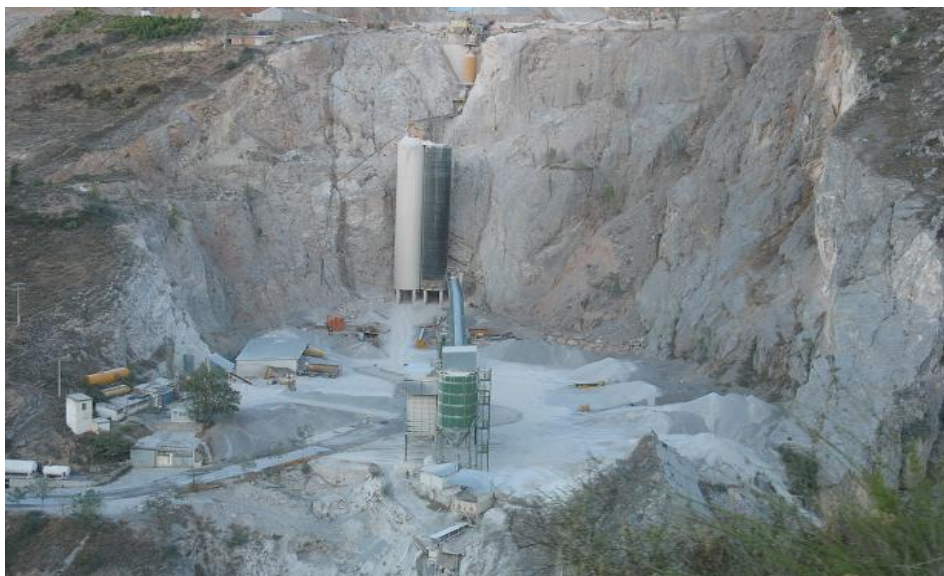
Figura 23-5. Explotación cementera cercana al cauce en Leza del Río Leza.
