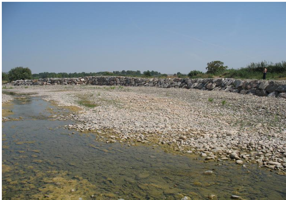
Figura 23-7. Escollera y alteración del lecho en la parte final del trazado del río Leza.
