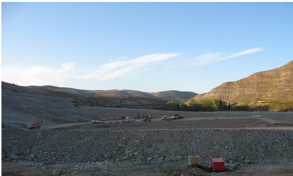
Figura 23-4. Obras de la presa de Terroba.
