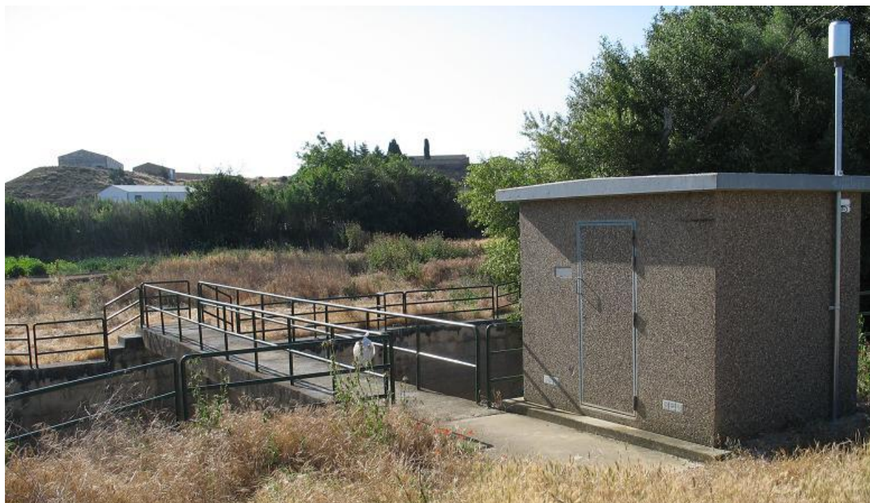
Figura 26-1. Estación de aforo del río Flumen en Barbués.
