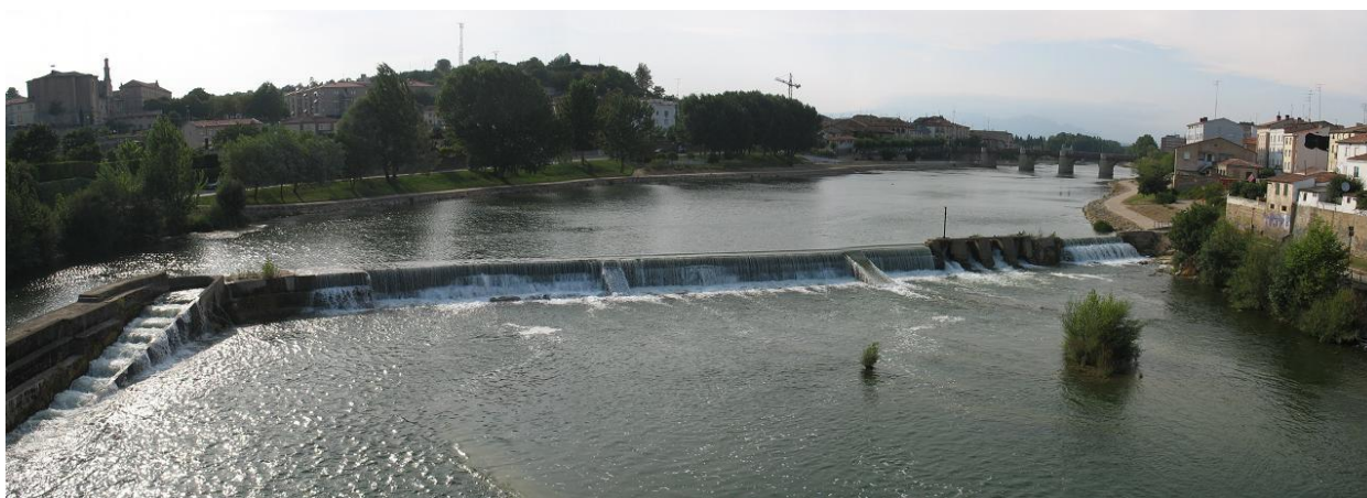
Figura 52-28. Azud en el tramo urbano de Miranda de Ebro.
