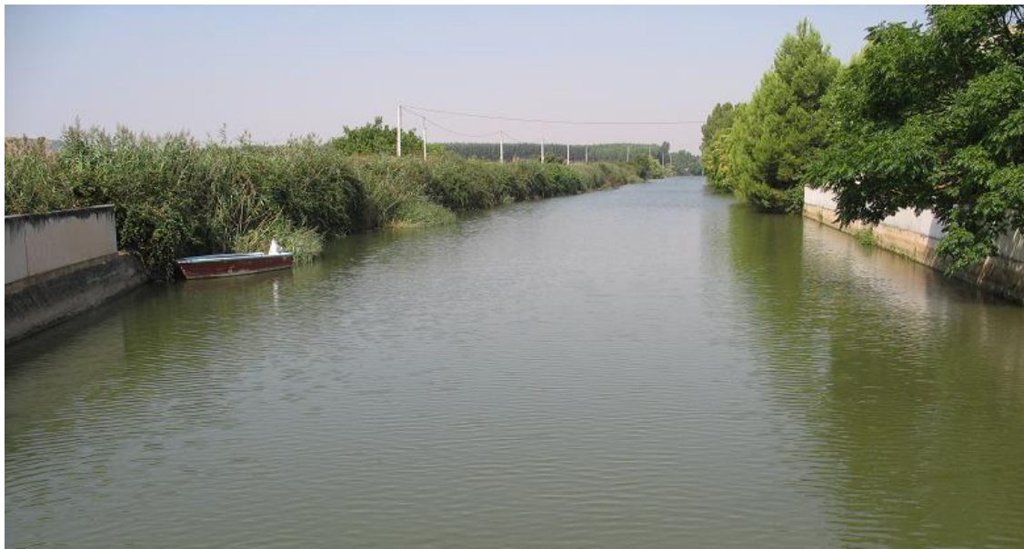
Figura 52-51. Canal de derivación hidroeléctrica.
