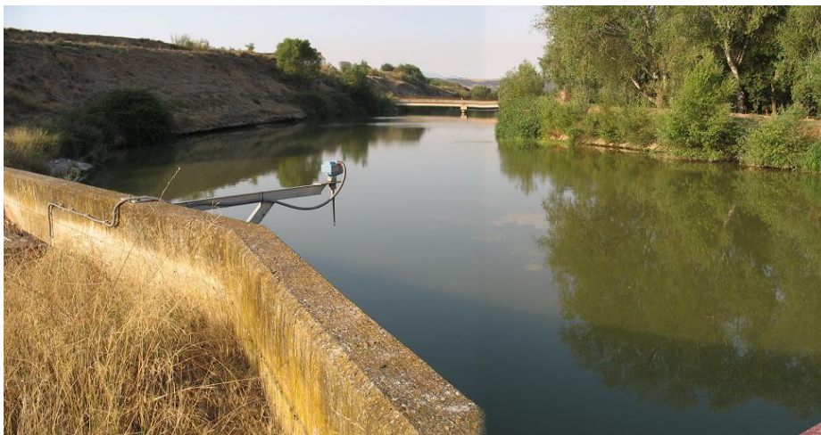
Figura 52-54. Canal de derivación hidroeléctrica de la central de Sartaguda.
