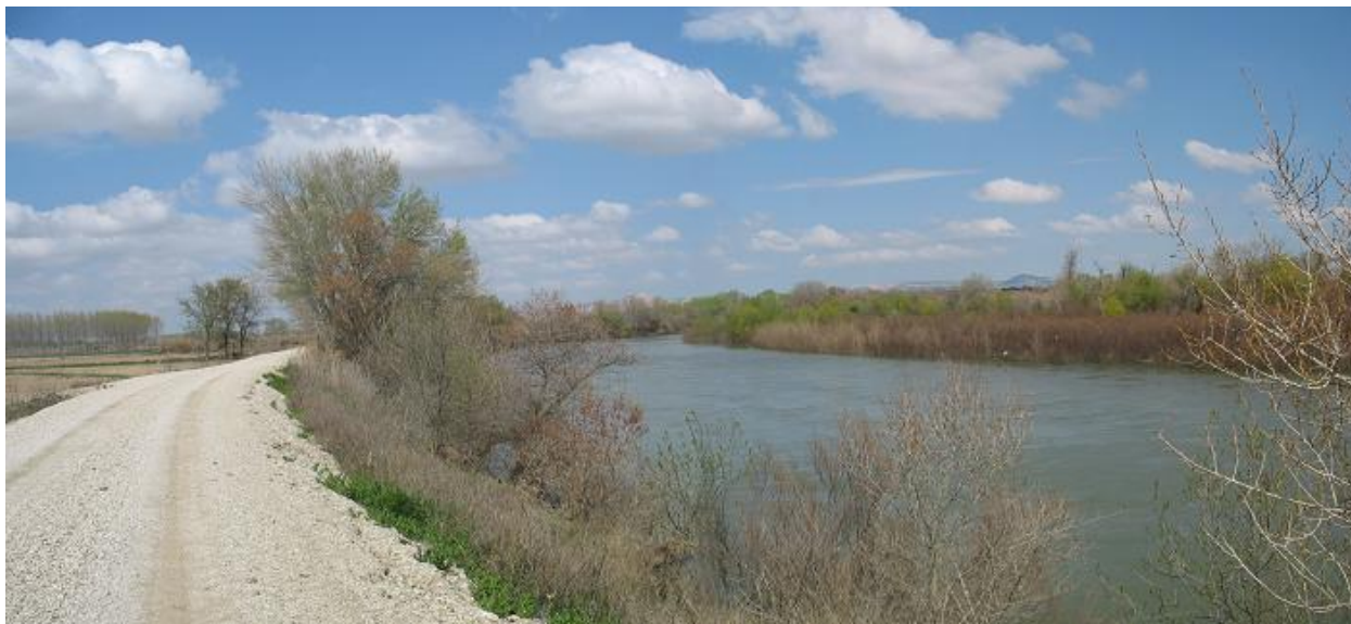
Figura 52-71. Motas laterales aguas abajo de Novillas
