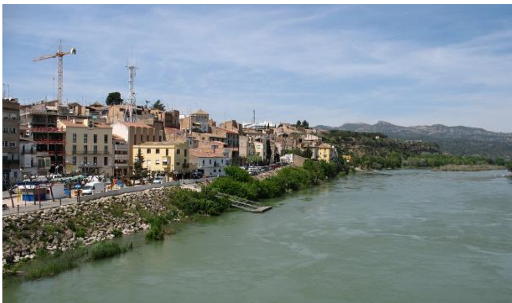
Figura 52-95. Defensas de margen en Mora de Ebro.
