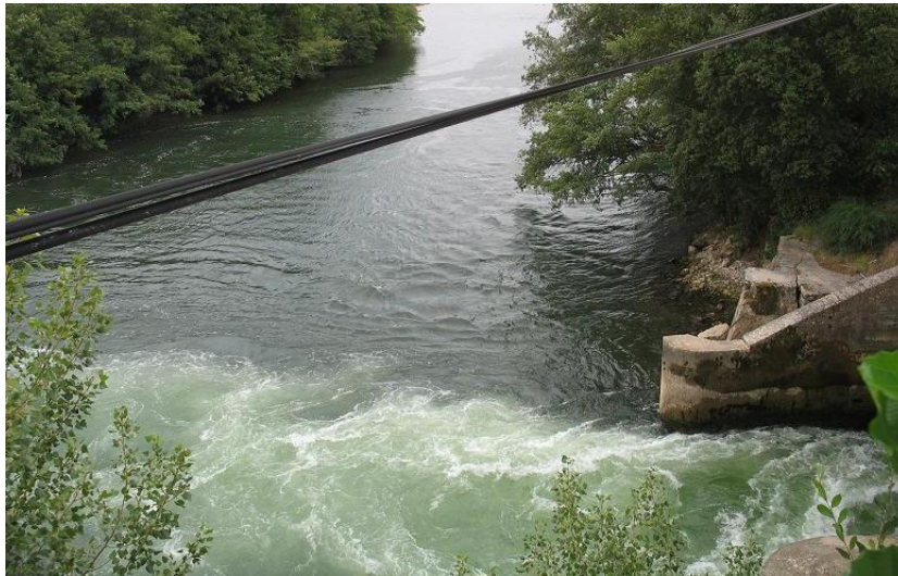
Figura 52-25. Salida de la Central de Sobrón.
