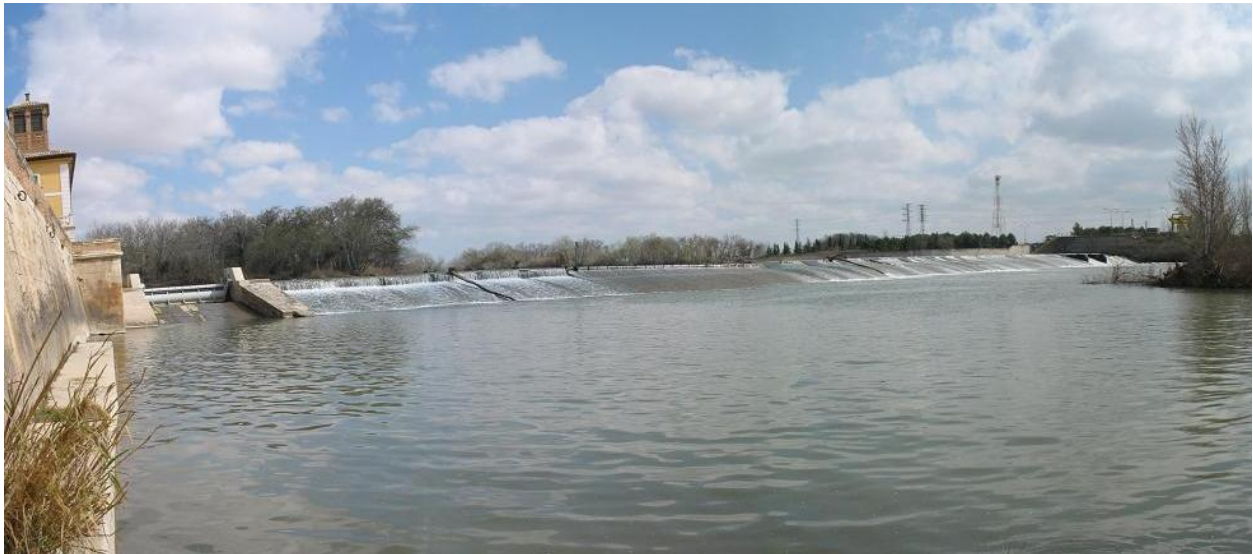
Figura 52-64. Azud de derivación aguas arriba de Tudela.
