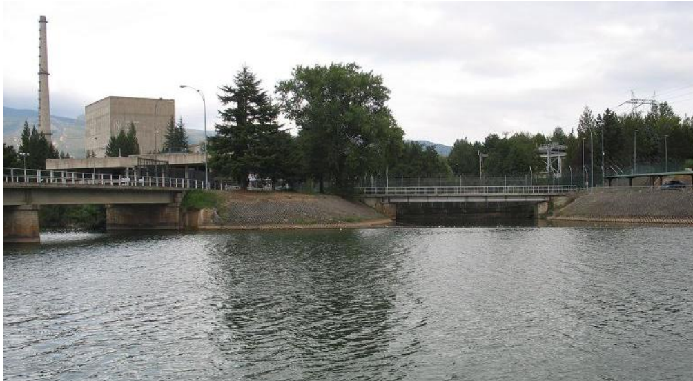
Figura 52-22. Entrada al canal de la central nuclear de Garoña.
