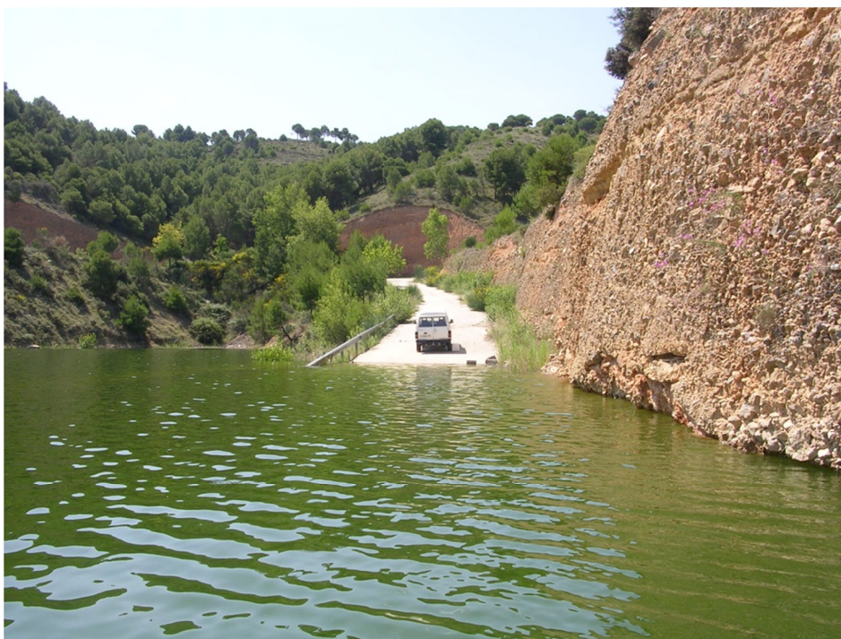
Figura 8. Vista del punto de acceso.
