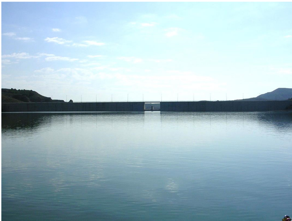
Figura 7. Vista de la presa del embalse.
