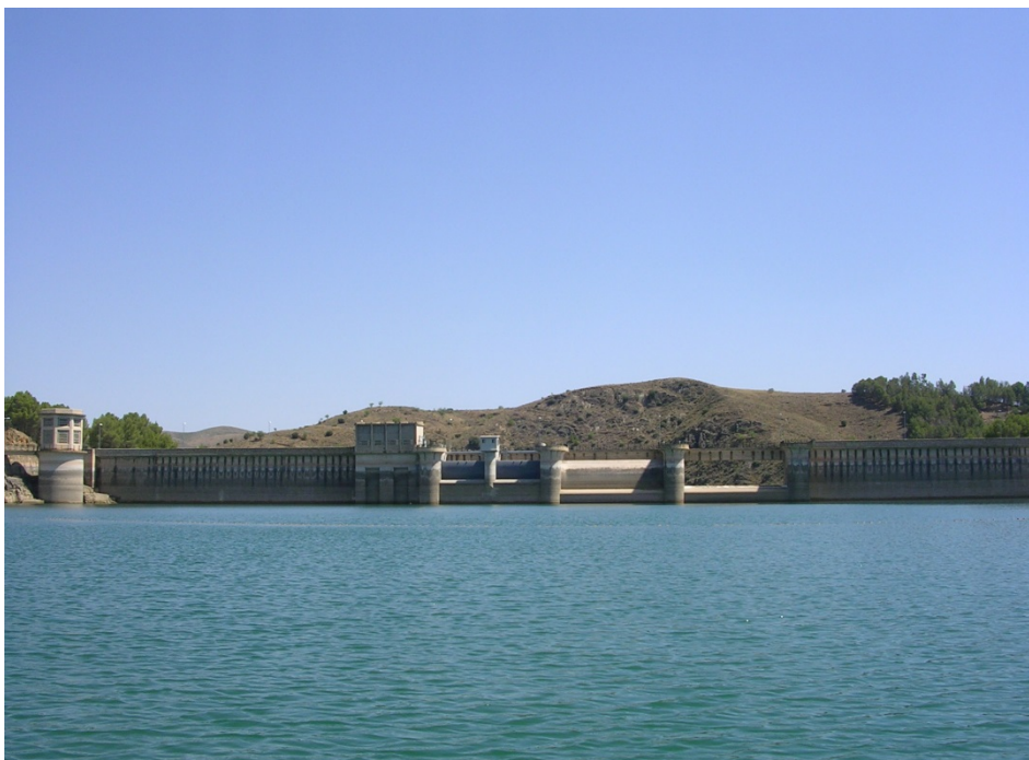
Figura 7. Vista de la presa del embalse
