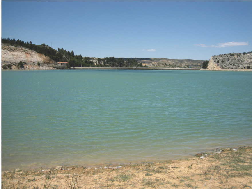
Foto 1: Vista de la presa del embalse desde el punto de acceso
