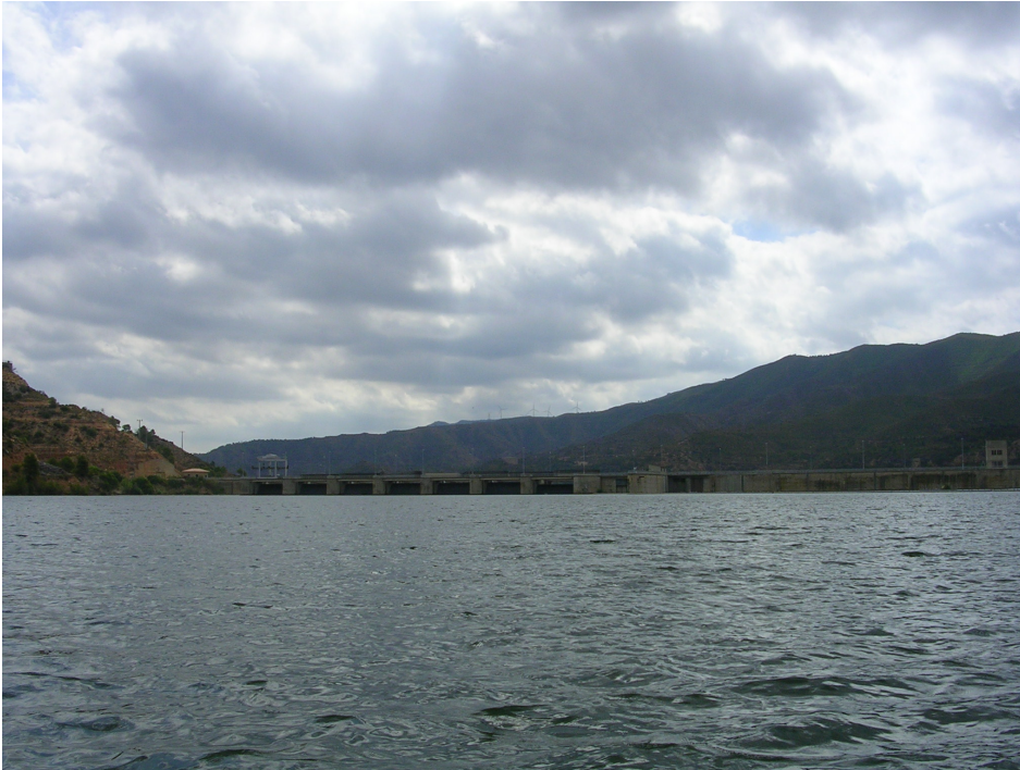
Figura 7. Vista de la presa del embalse
